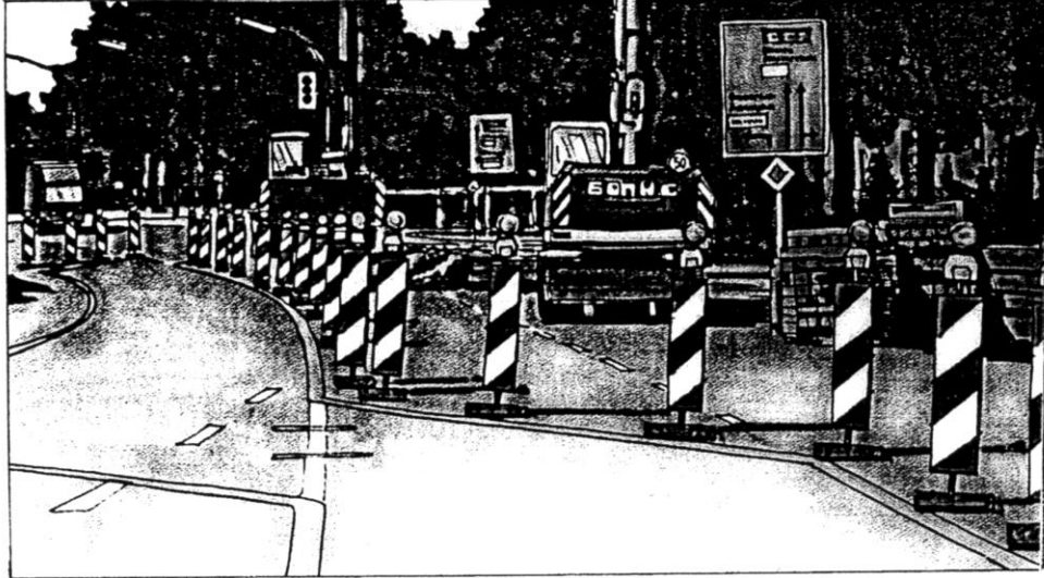
DETALLE DE BALIZAMIENTO PARA CIRCULACIÓN RODADA EN ZONA DE OBRAS
