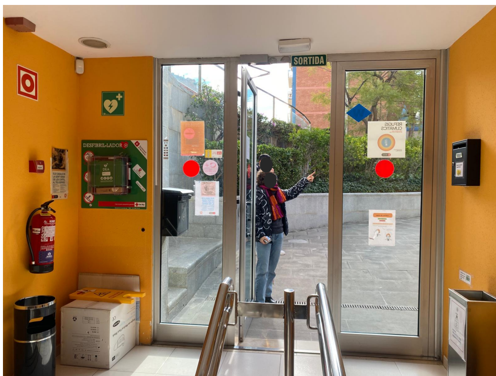
▲ Vista interior de la porta a substituir.
