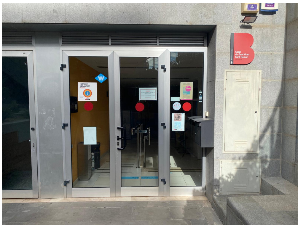
▲ Vista exterior de la porta a substituir.
