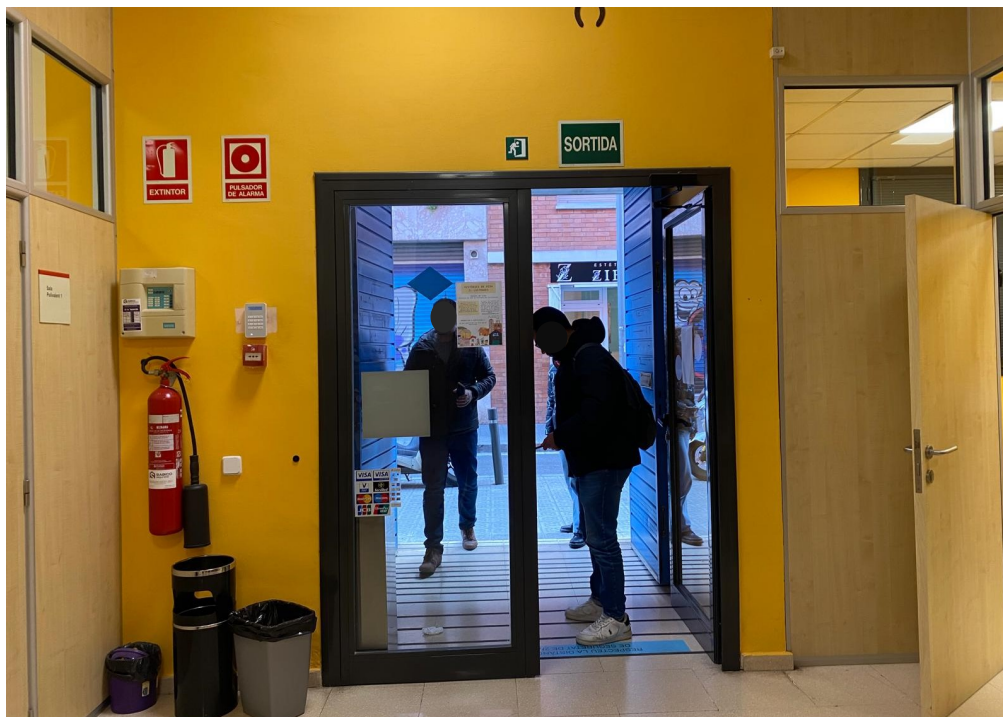
▲ Vista interior de la porta a substituir.
