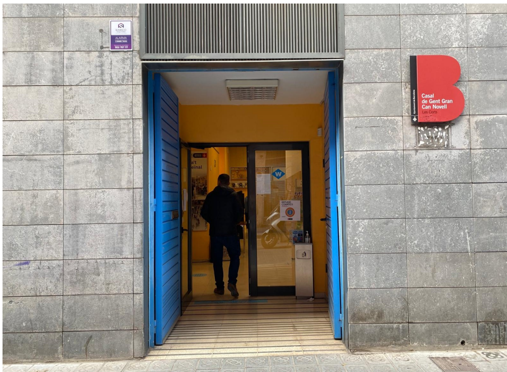
▲ Vista exterior de la porta a substituir.
