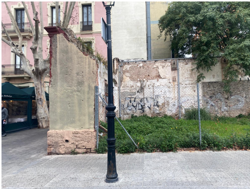
▲ Trobada actual de la tanca amb el mur (1)
