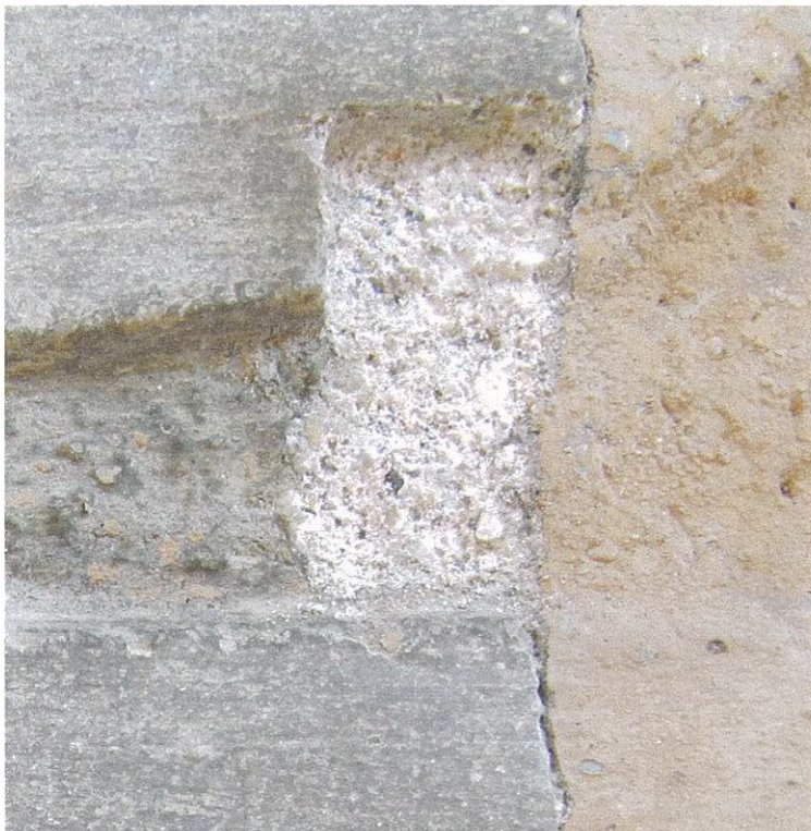
Fotografia de detall del sondatge 20, realitzat en un fragment de fris, on veiem que el morter MB està com a base i com a superfície d'acabat del esgrafiati de les zones rascades.
