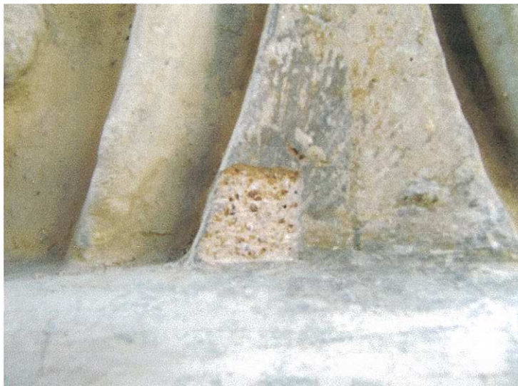
Fotografia de detall del sondatge realitzat en un dels capitells de la façana. Sobre la capa de morter MTX trobem la CP1 de color més fosc i a sobre d'aquesta la CP2 d'un color una mica més clar.
