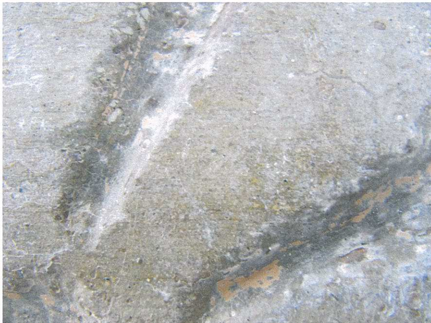
Fotografia de detall del sondatge núm.11, realitzat en la decoració de l'emmarcament d'un balcó, on veiem la CP2 amb els dos tons anteriorment descrits que potencien els volums de la façana enfosquant les zones que queden més enfonsades i aclarint les que sobresurten.
