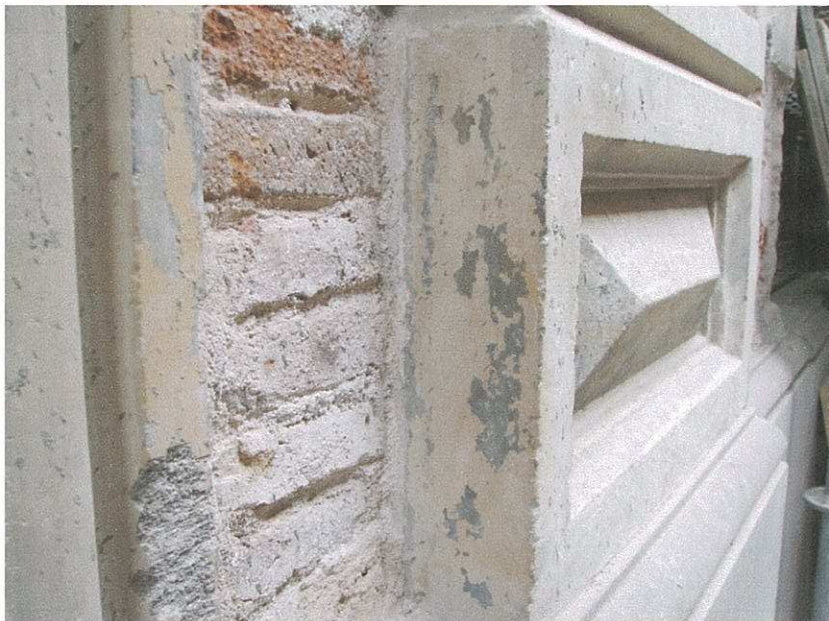
Fotografia del SPP, on es veuen els maons i el gruix de la separació de les juntes de morter, després d'eliminar els morters sobreposats. Part inferior de la façana.
