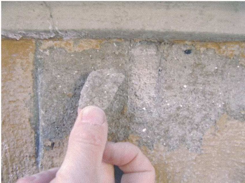
Fotografia de l'extracció d'una mostra de MT, del sondatge 15. Es veu una zona en la que es poden apreciar amb facilitat els nòduls de calç del morter i de carbó.
