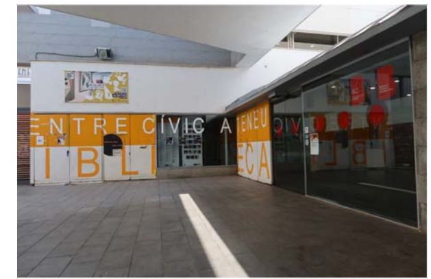
VISTA GENERAL EXTERIOR. TANCAMENT LATERAL. SORTIDA EMERGENCIA SOTERRANI BÚSTIA RETORN I CORREU.
