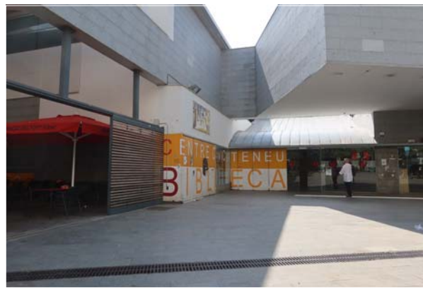
VISTA GENERAL EXTERIOR. ACCÉS CENTRE CÍVIC ATENEU FORT PIENC
