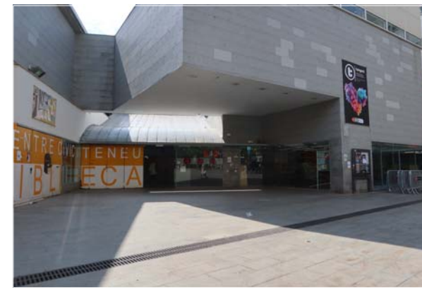
VISTA GENERAL EXTERIOR. TANCAMENT FRONTAL. ACCÉS
