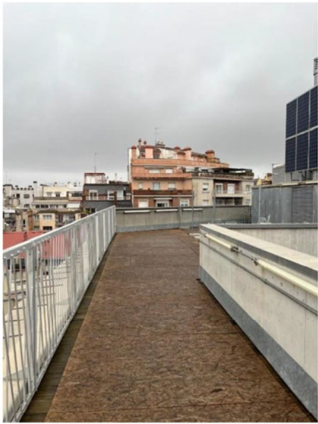
Terrassa Planta Sisena. Fotografia general 1
