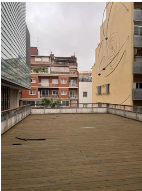
Terrassa Planta Primera. Fotografia general 1
