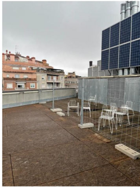
Terrassa Planta Sisena. Fotografia general 2
