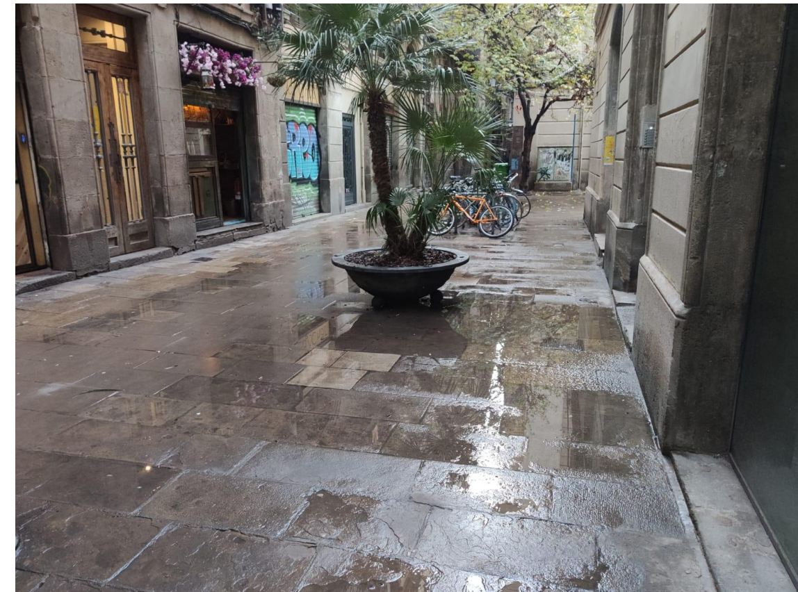
Figura 3. Estat actual del carrer.
