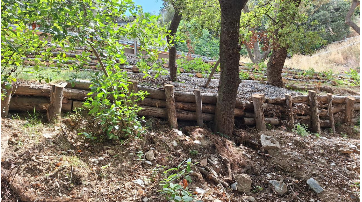
Tram central del Krainer amb les palissades lleugerament inclinades i el xaragall central
