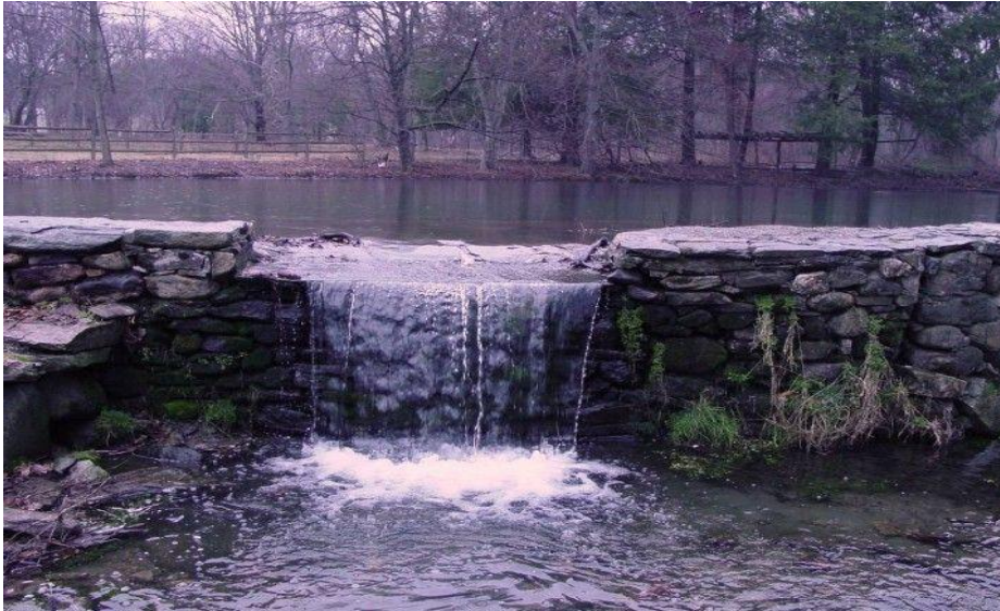
Imatge d'un dic de maçoneria, referent per a la segona bassa
