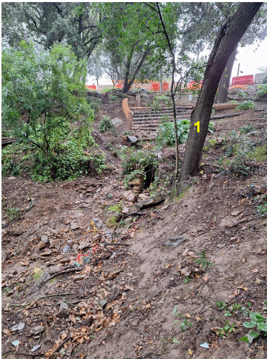
Zona on es preveu construir la primera bassa (arbre 1)
