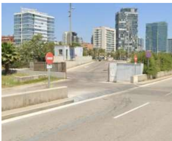
Imatge de l'accés de vehicles i de la rampa
