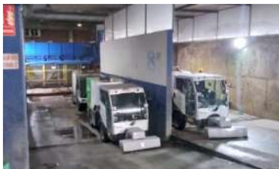
Imatge planta -1: zona tècnica vehicles
