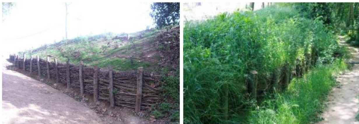
Figura 48 Exemple de palissades amb brancatge executades per Naturalea
