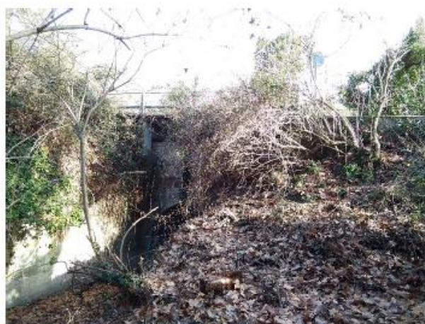
Figura 16 Restes vegetals a retirar en el tram 3.2
