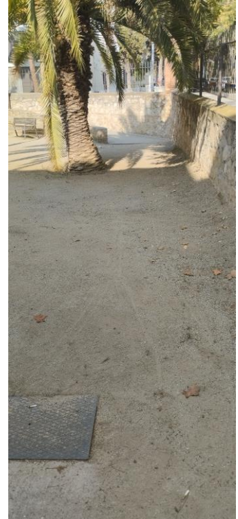
Imatge de la ubicació de la passera lateral. Dimensions aproximades 19 x 2'5m Actualment sense solera, i de sauló compactat
