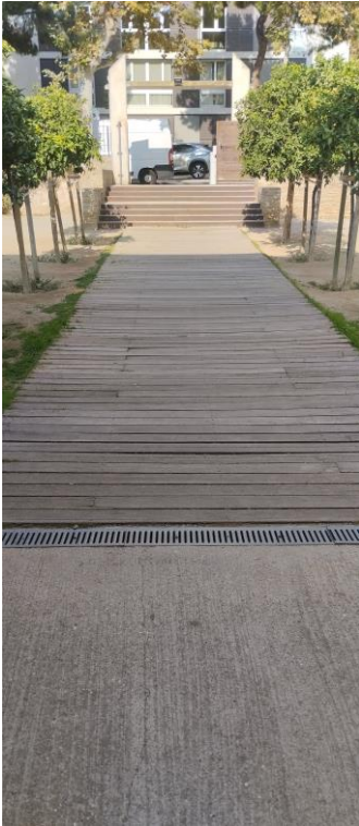
Imatge de la passera central. Dimensions aproximades 16 x 5m Material: Entarimat a base de fusta tropical sobre rastells
