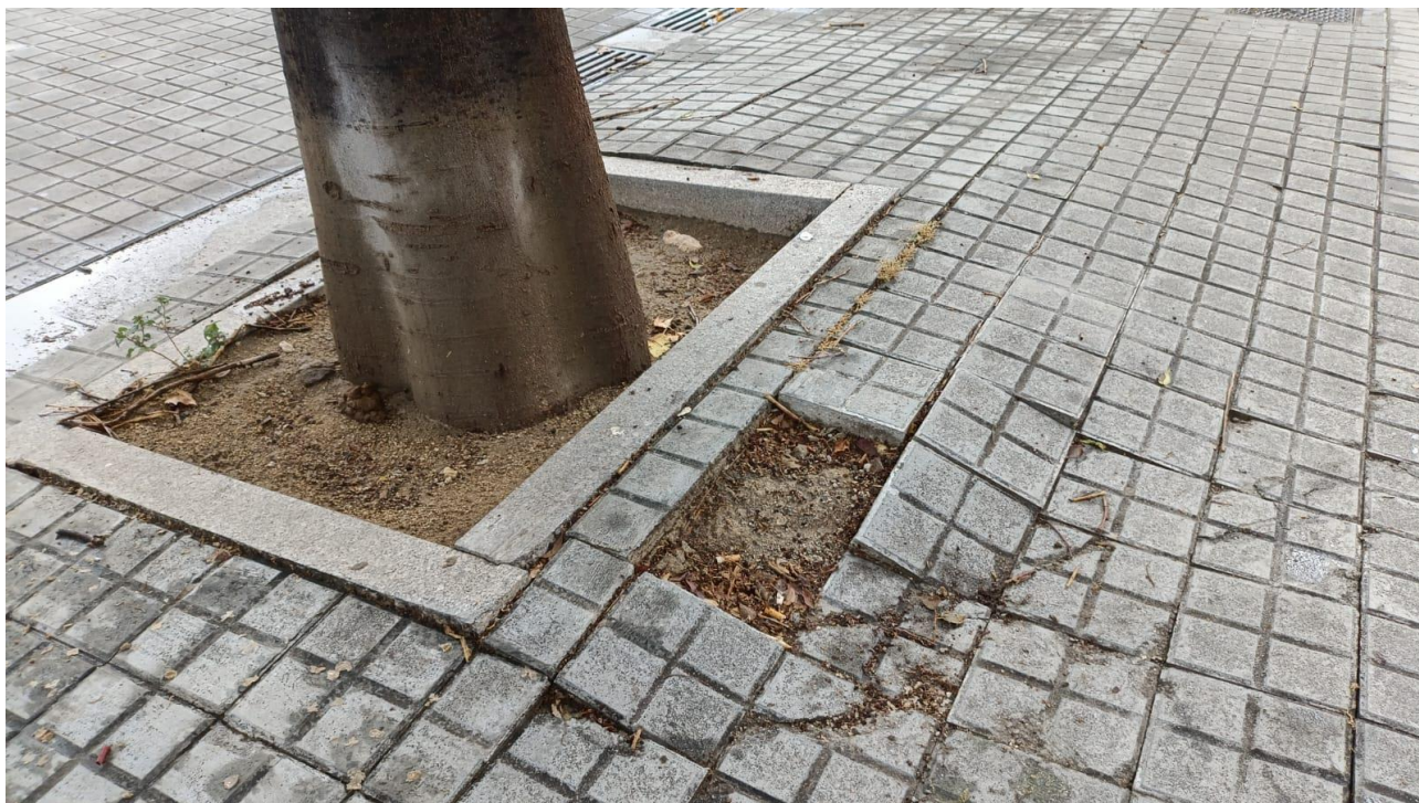
▲ Detall malmès al voltant d'un escocell
