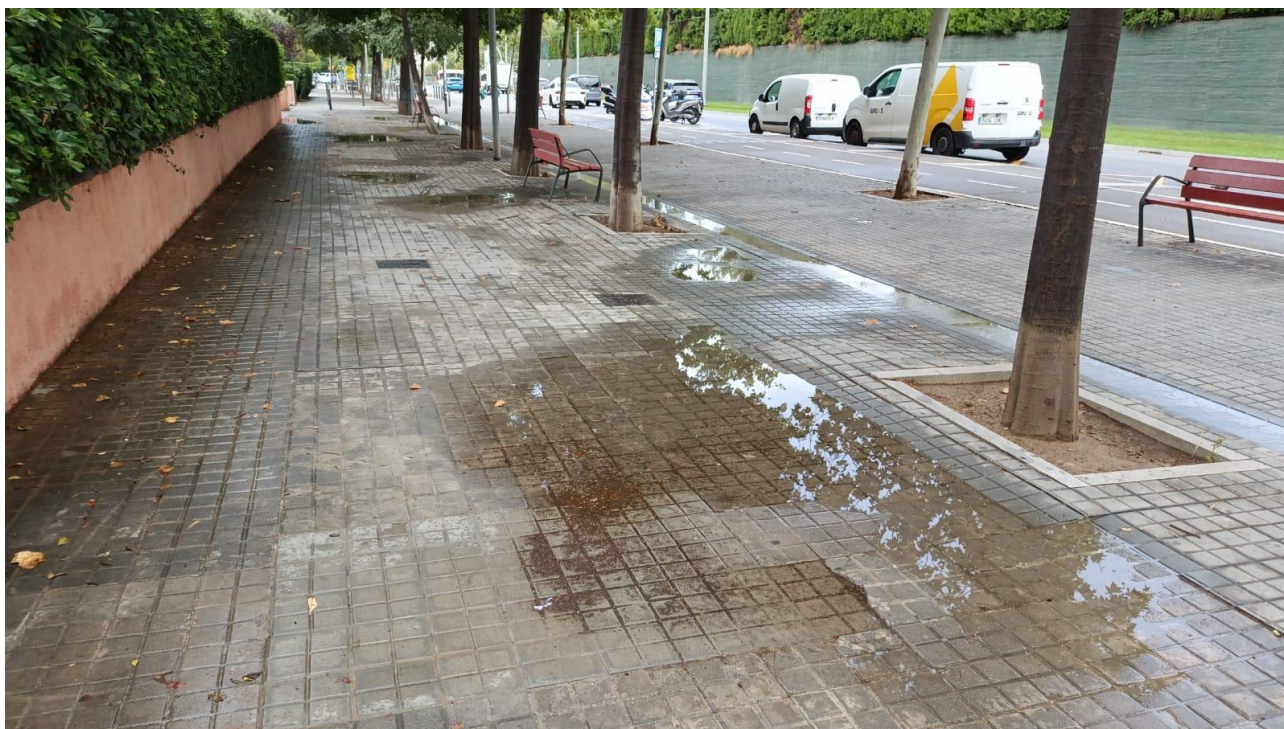
▲ Vista general en direcció cap al carrer de Pisuerga I
