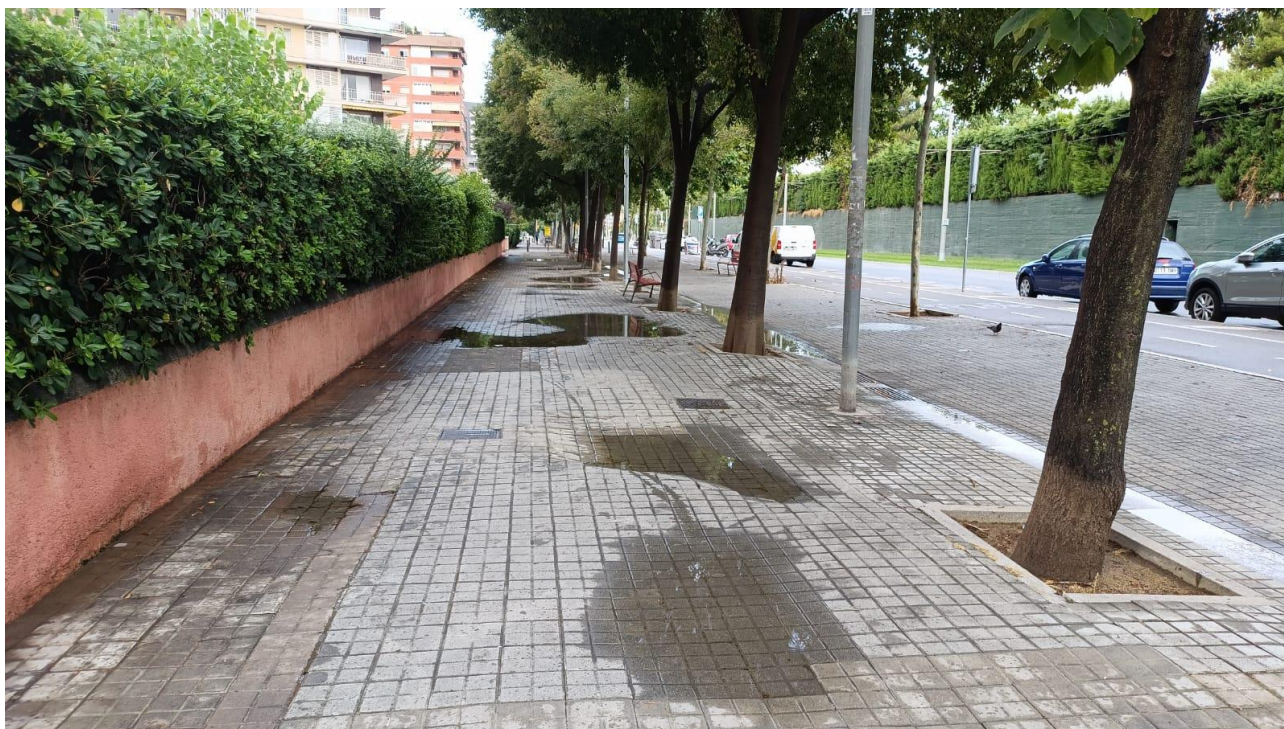
▲ Vista general en direcció cap al carrer de Pisuerga
