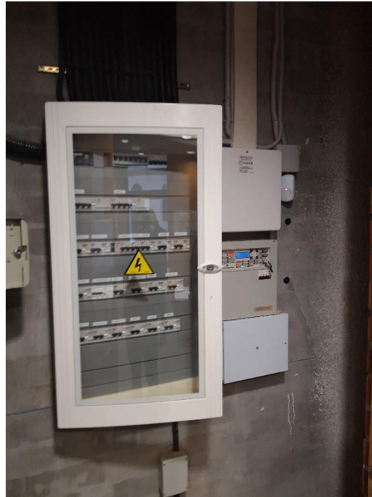
Estat actual recinte Quadre Electric existent
