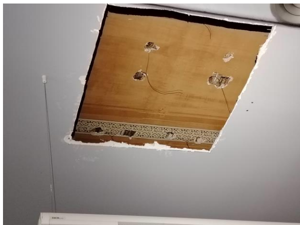
Al descobrir-se la pintura original es van obrir més cales
