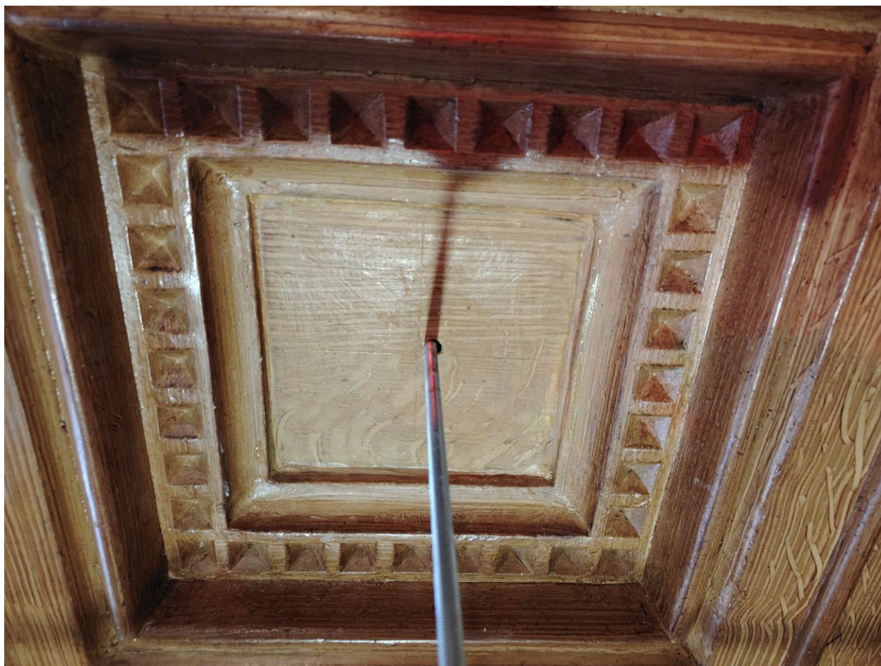
Resultat final d'un dels plafons recol·locat
