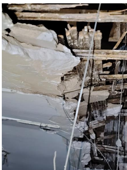
Sostre 2, part del saló en estat ruïnós, detall de la motllura-rosetó repintada en blanc
