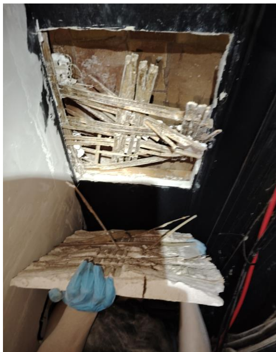
Detalls de la realització de la cala i vista del forjat
