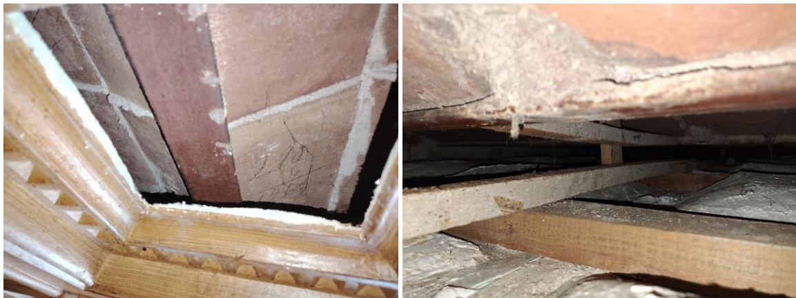
Vistes de l'estructura del forjat després de l'extracció dels plafons
