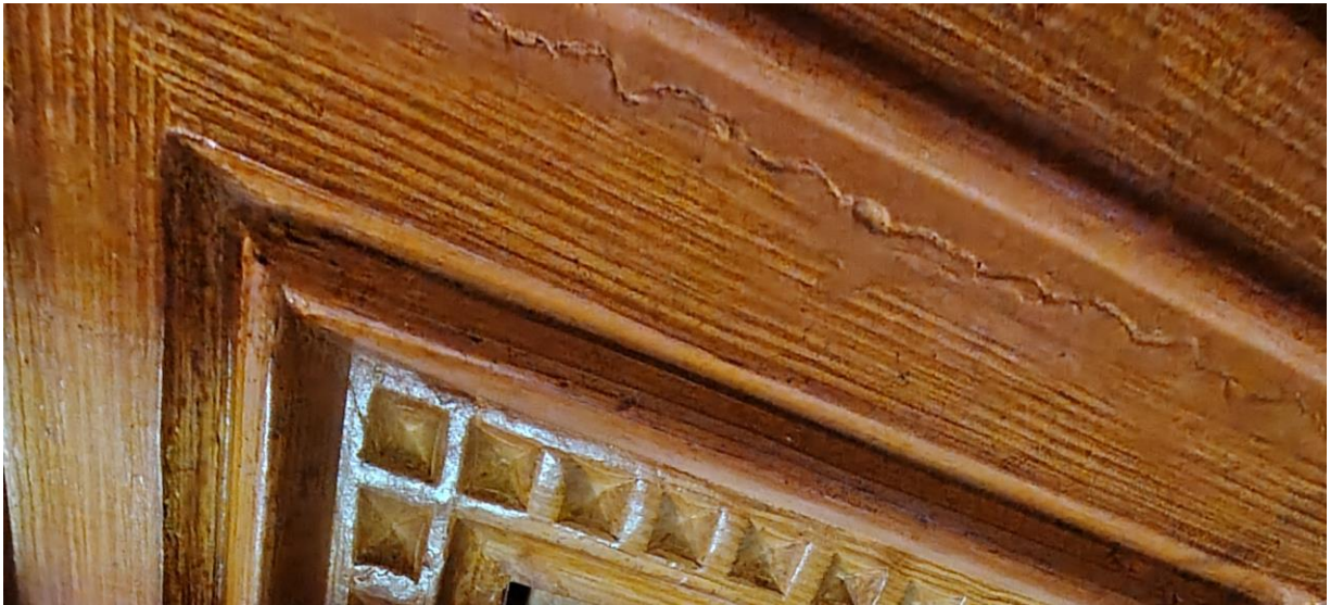
Intervenció anterior, esquerra reintegrada sotanivell amb massilla de color
