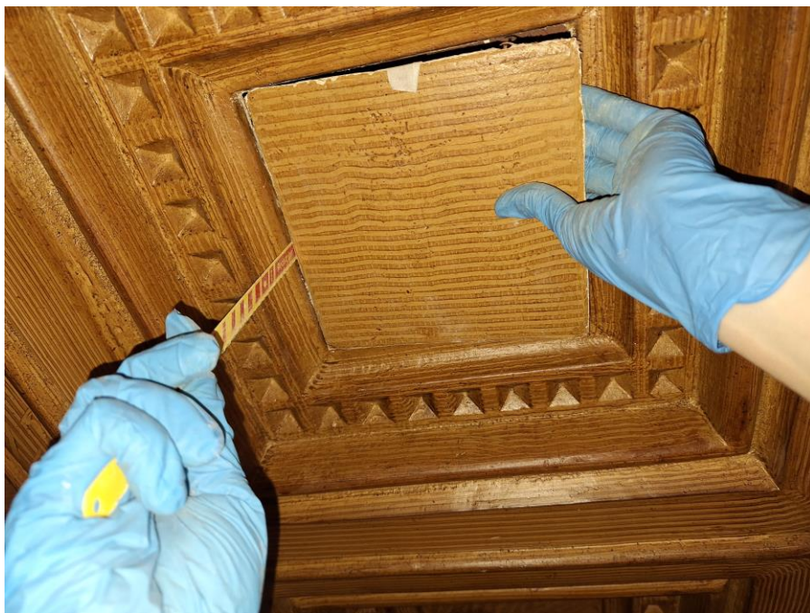
Detall de l'extracció del primer plafó de guix
