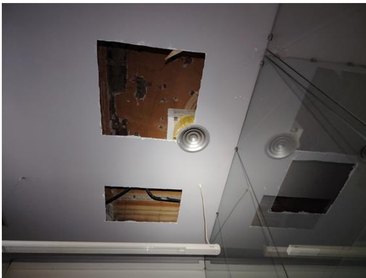
Primeres cales al fals sostre on es va veure el color original i el vestigi de la sanefa modernista
