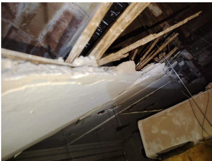
Sostre 2, part del saló en estat ruïnós, detall de la motllura-rosetó repintada en blanc
