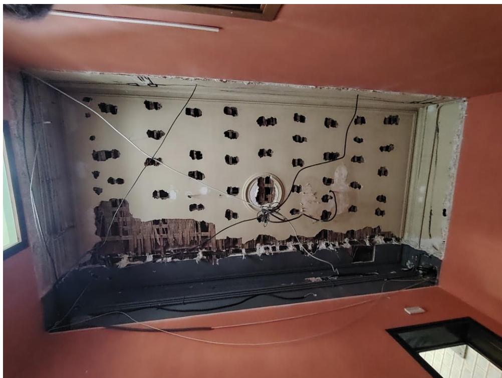
Vista del sostre original del saló a la dreta del vestíbul després de retirar el fals sostre
