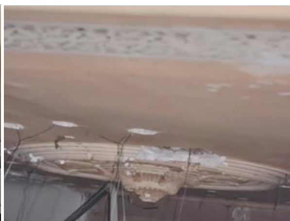
Al descobrir-se la pintura original es van obrir més cales
