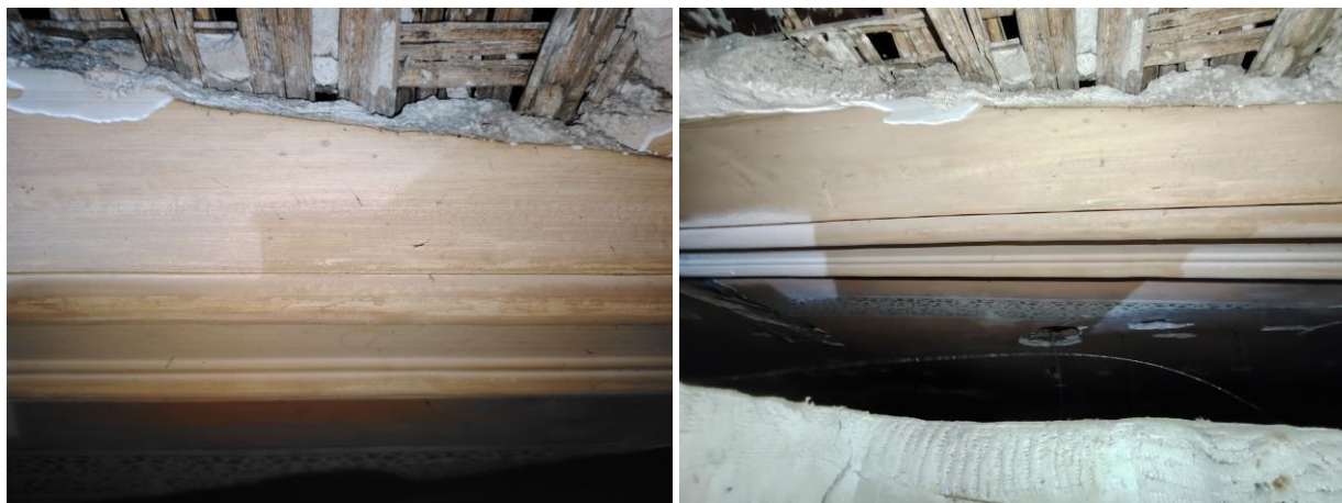
Primeres cales al fals sostre on es va veure el color original i el vestigi de la sanefa modernista
