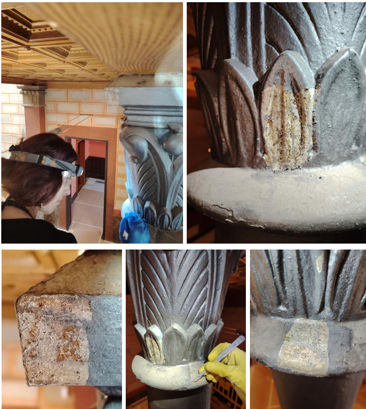
Detalls de l'eliminació de capes al capitell
