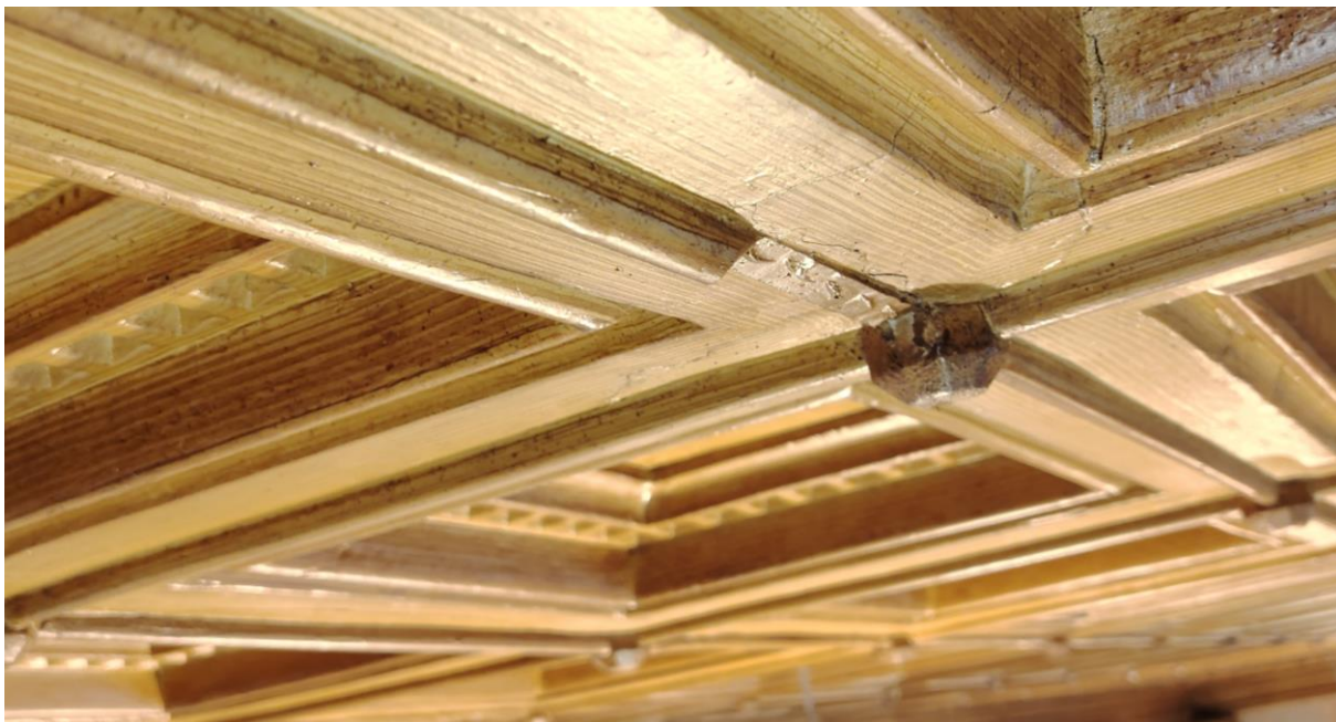
Intervenció anterior, pèrdua de suport reinetgrada cromàticament
