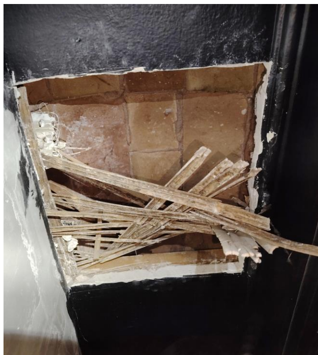
Detalls de la realització de la cala i vista del forjat
