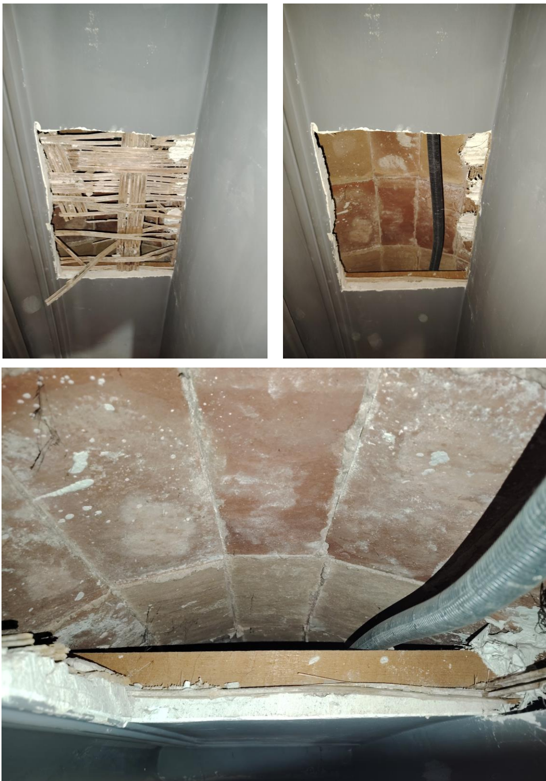
Vista del forjat després de la realització de la cala
