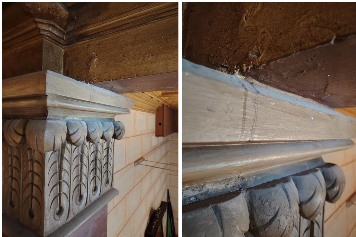
Detalls dels regalims de l'acabat del sostre i distinció de la imitació de fusta entre el capitel i sostre
