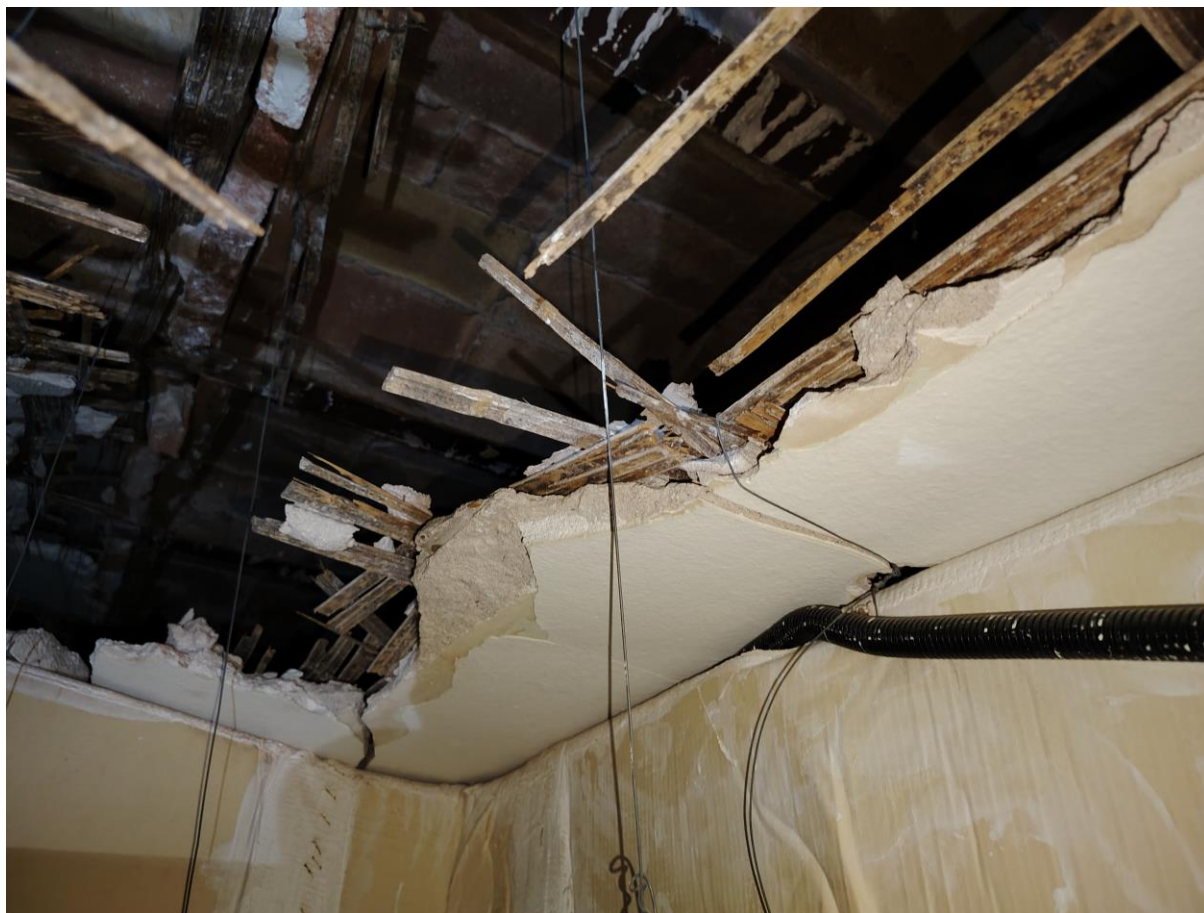
Vista de l'estat ruïnós del sostre original d'un dels salons laterals
