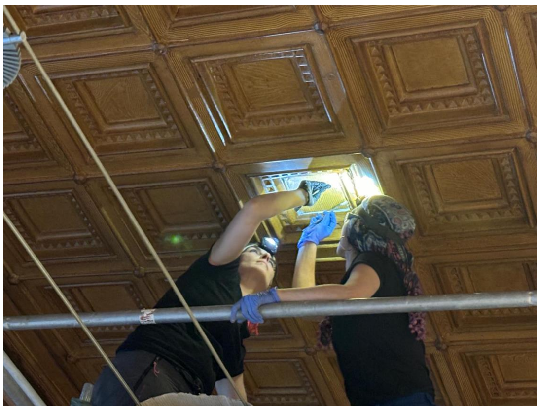
Estucat de les zones obertes pròpies de l'extracció
