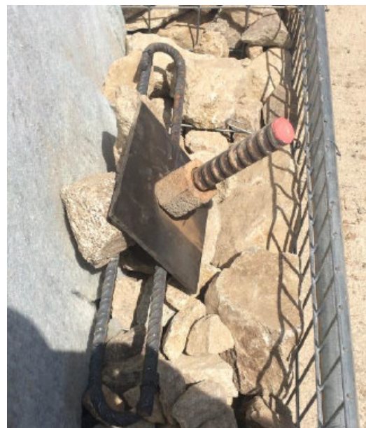
Imatges d'exemple de gabions ancorats amb bolons i sistema d'ancoratge de bolons amb placa de repartiment
