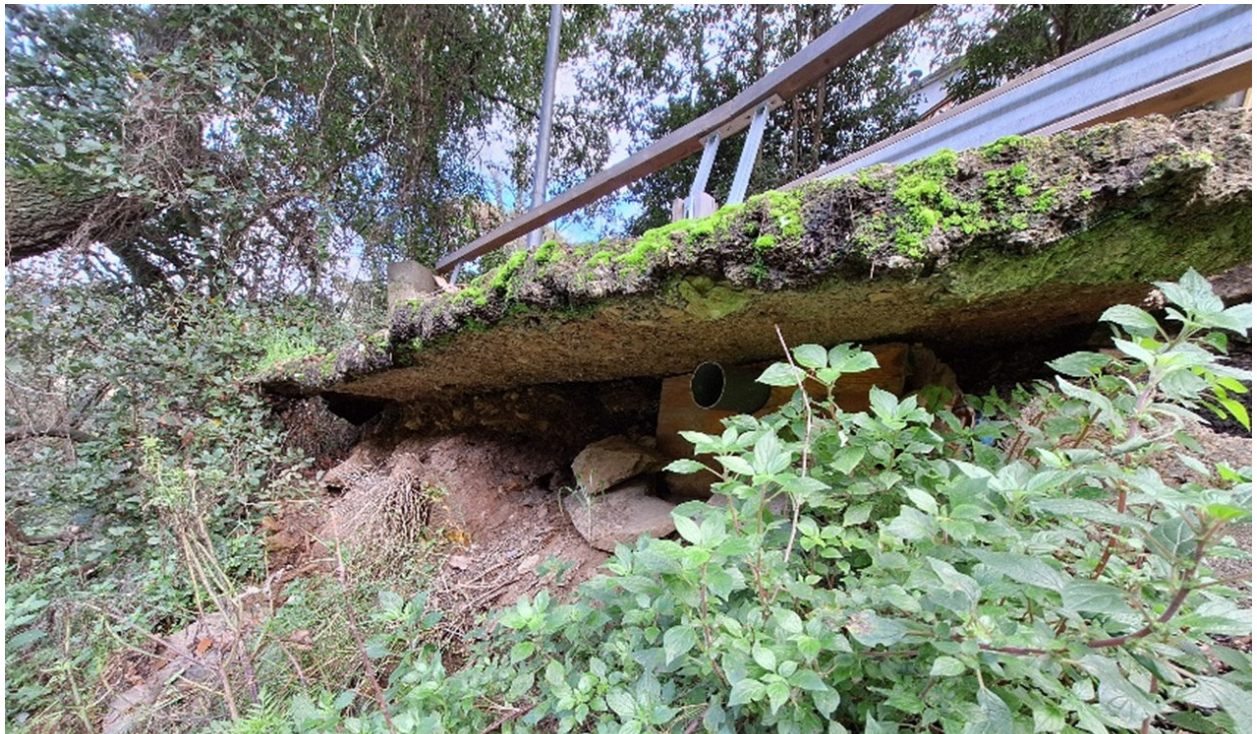
Fotografies de l'estat actual del camí interior de Mas Guimbau: Àmbit A
