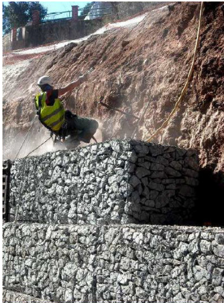
Imatges d'exemple de gabions ancorats amb bolons i sistema d'ancoratge de bolons amb placa de repartiment
