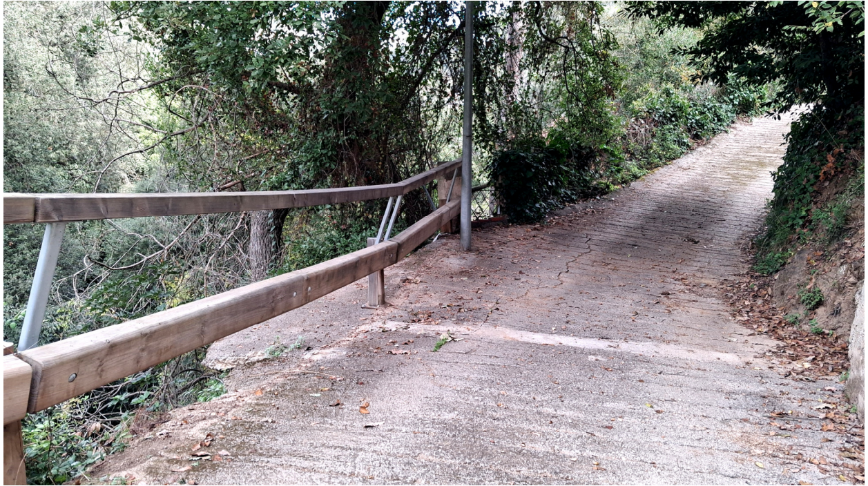
Fotografies de l'estat actual del camí interior de Mas Guimbau: Àmbit A
