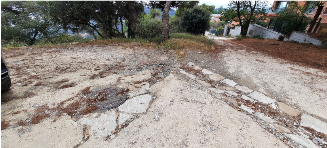
13. Zona final del gual amb trenca i trapa existent
