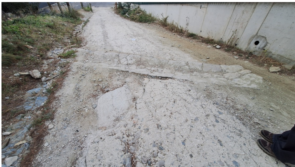
8. Zones de les trenques on les rodes dels cotxes han erosionat els punts previs i posteriors
