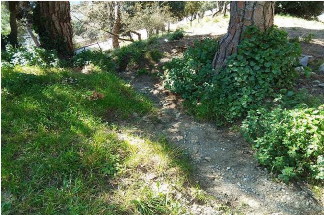
17. Punt del talús de la part alta del camí per on desaiuarà la cuneta empedrada
