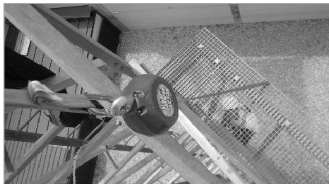
Figura 4. Ejemplo posicionamiento incorrecto dispositivo retráctil
