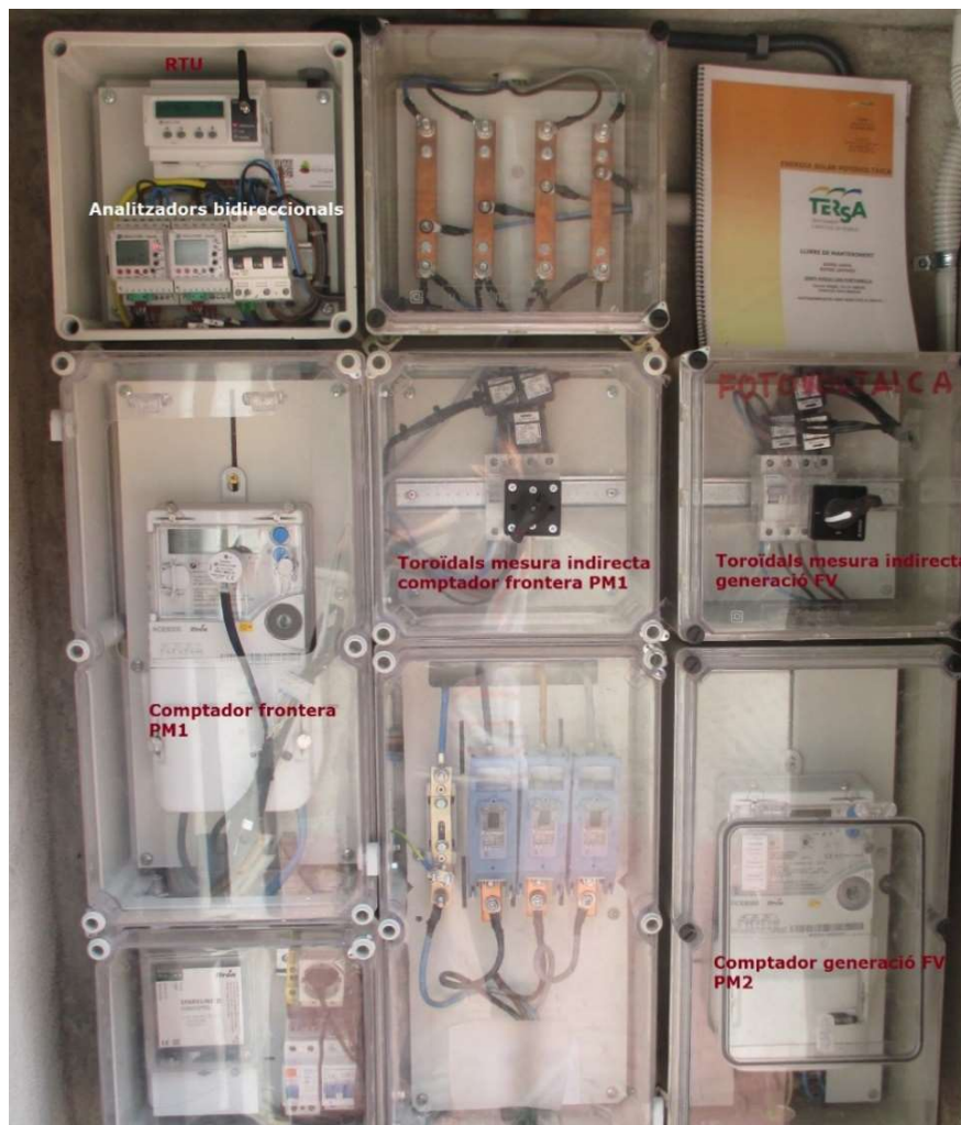
Exemple monitorització comptadors PM1 i PM2 mitjançant mesura indirecta
