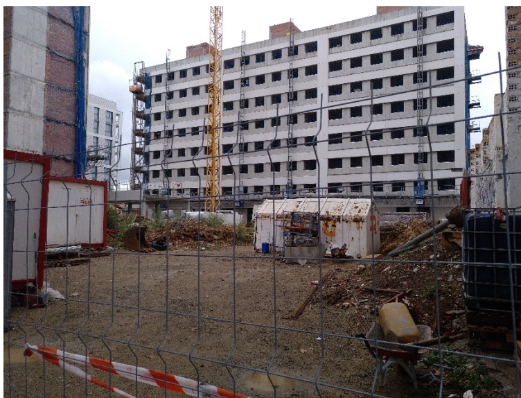
Figura 1. Vista del solar on es construirà l'edifici de mòduls APROP (instantània feta el setembre de 2020).
