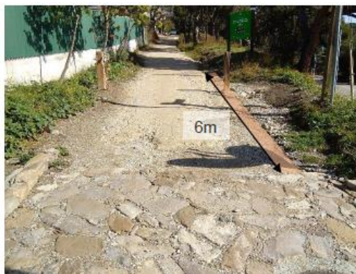
15. Esquema cuneta amb elements d'ancoratge i dissipació de l'energia de l'aigua
