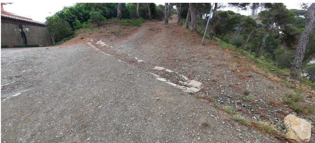
11. Trenques superiors amb gran quantitat de sediments
