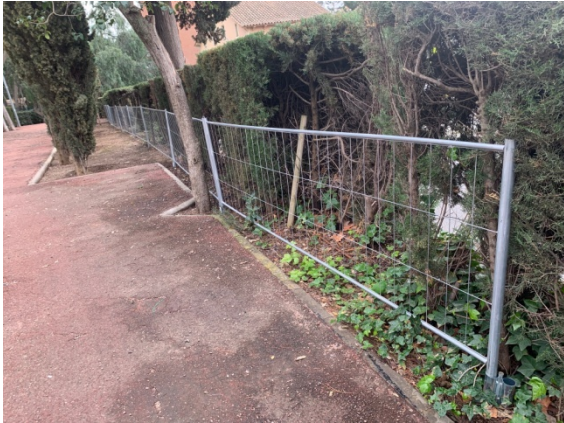
Tancament de parterre existent
