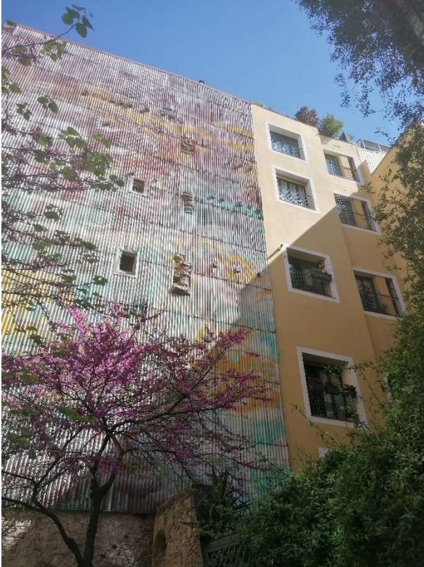
Façana Posterior Edifici Pescateria 2
