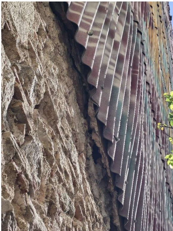
Pluvial de placa asfáltica tipus onduline a derrocar
