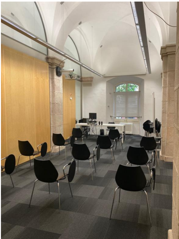
Envans existents a substituir per envans mòbils.
