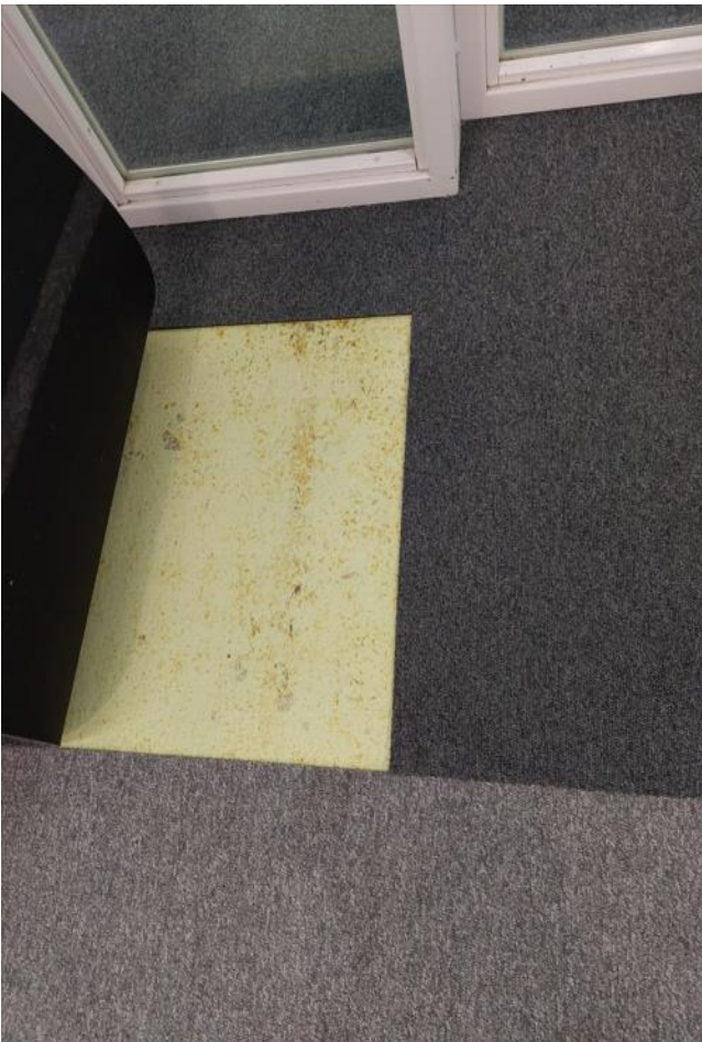
Figura 9: Paviment resines existent sota la moqueta. I mampares existents sobre paviment resines.
