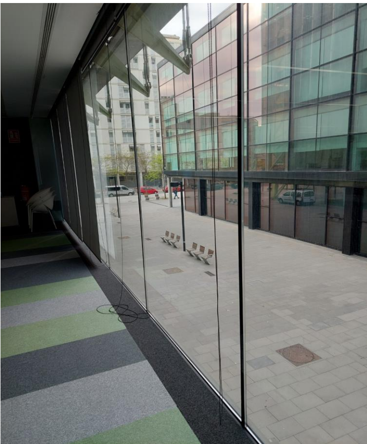
Figura 7: Remat moqueta en façana
