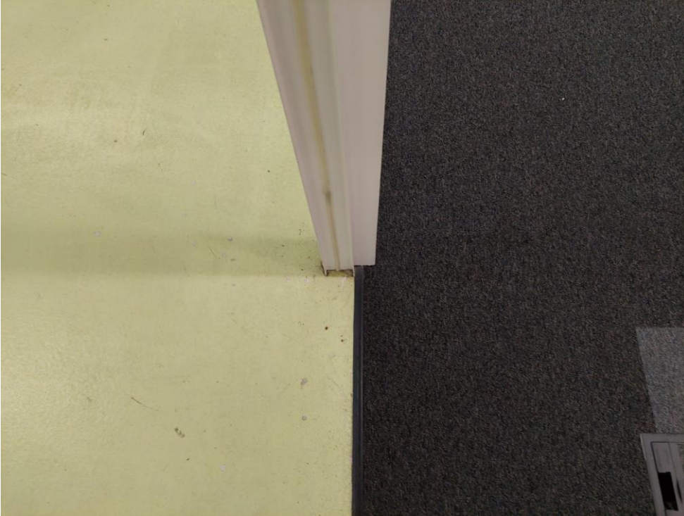
Figura 8: Paviment resines passadís i paviment moqueta
