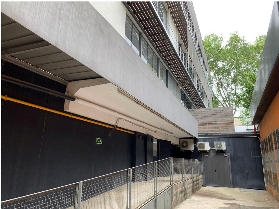
IMATGE 10 ↘ VISTA DES DE SOTA DE LA PART FINAL I PASSERA
