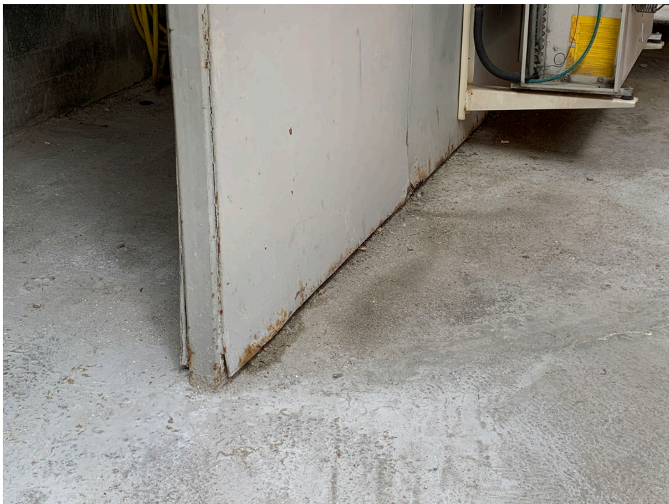
IMATGE 12 ↘ XAPA ROVELLADA AL PEU DE LA PLANTA SOTERRANI
