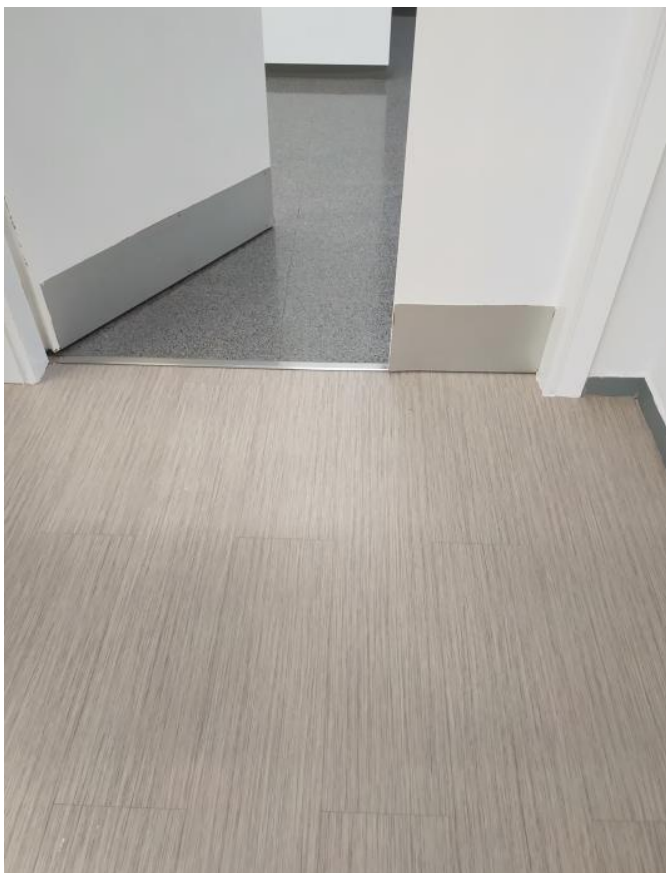
Figura 16: Platina canvi paviment, en porta accés mòduls.
