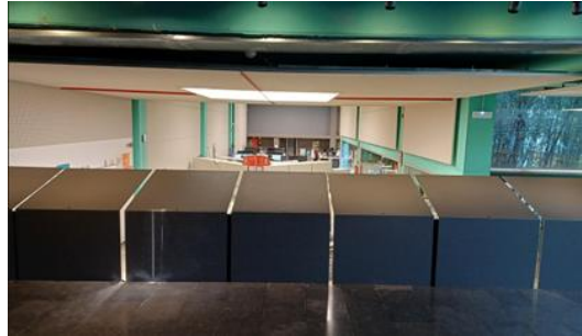
Peces laterals de l'estructura metàl·lica
