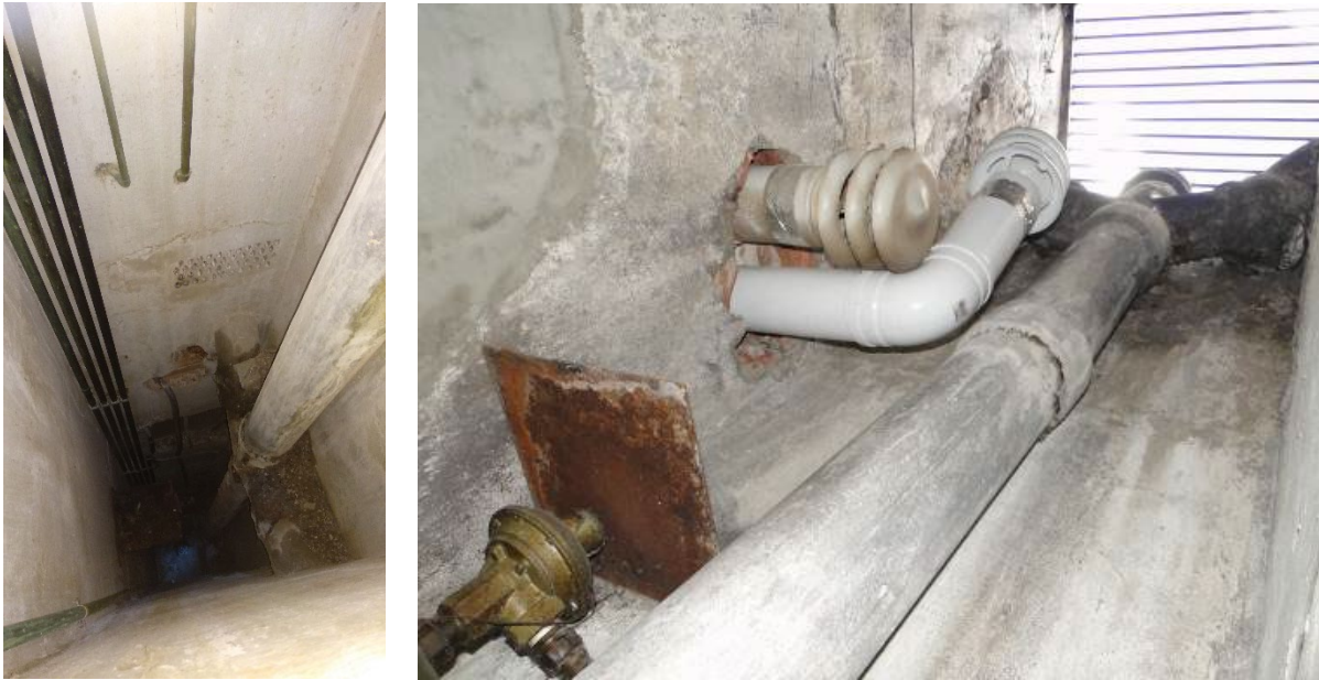
Imatge 24-25. Vistes del pati de les portes segones.
