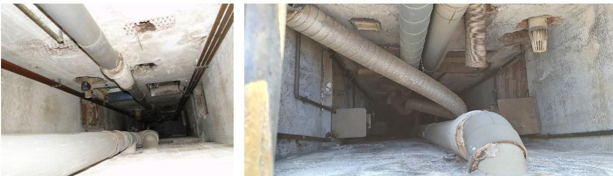
Imatge 26-27. Vistes de la xarxa de sanejament.
