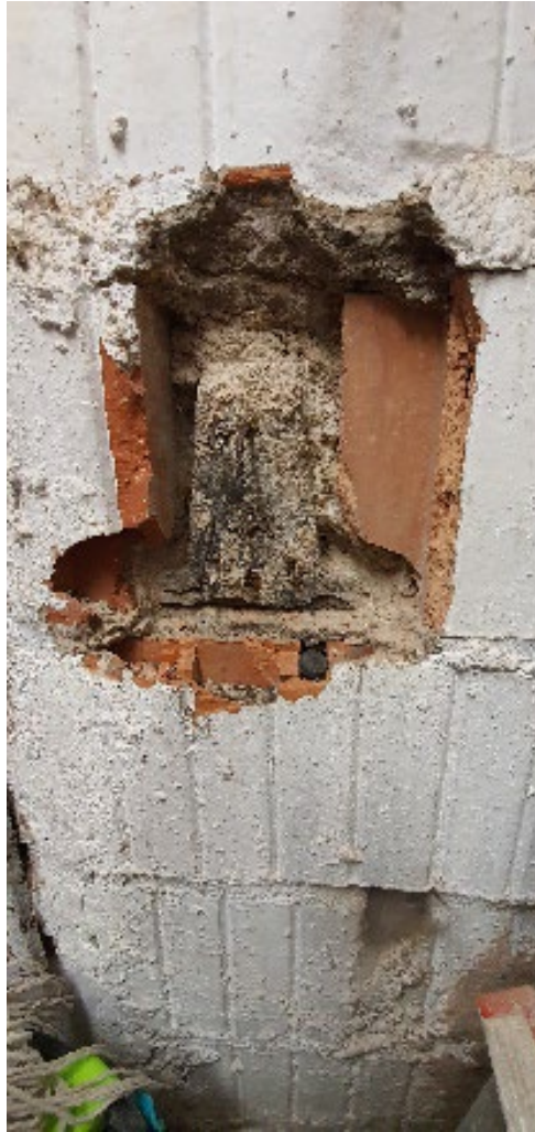
Imatge 4. Vista d'una bigueta recolzada en el mur portant.
