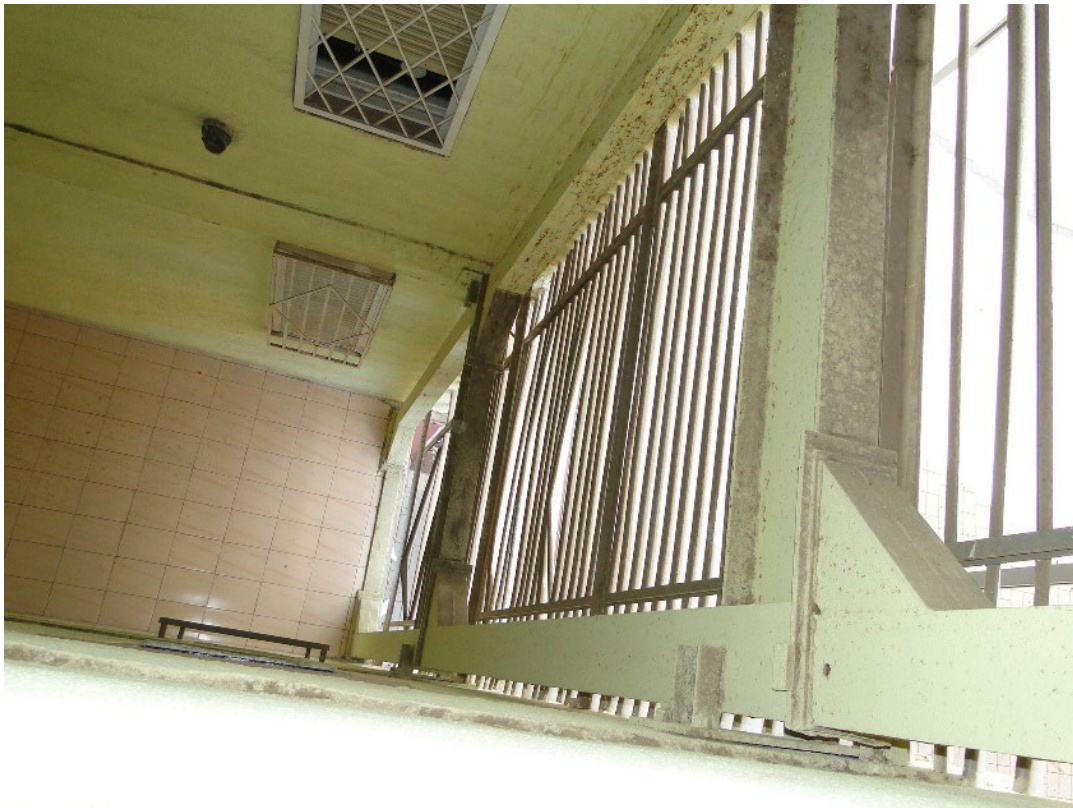
Imatge 8. Vista en detall dels reforços de trava realitzats en la façana del c/ Messina.
