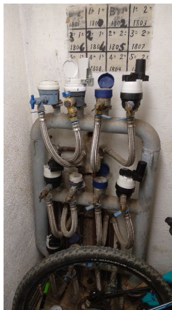
Imatge 30. Vista de la bateria de comptadors.
