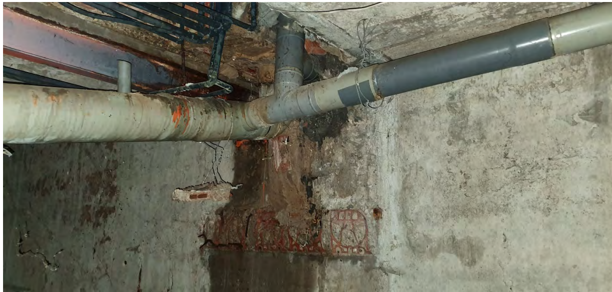
Imatge 10. Vista de reforç existent en cambra sanitària.
