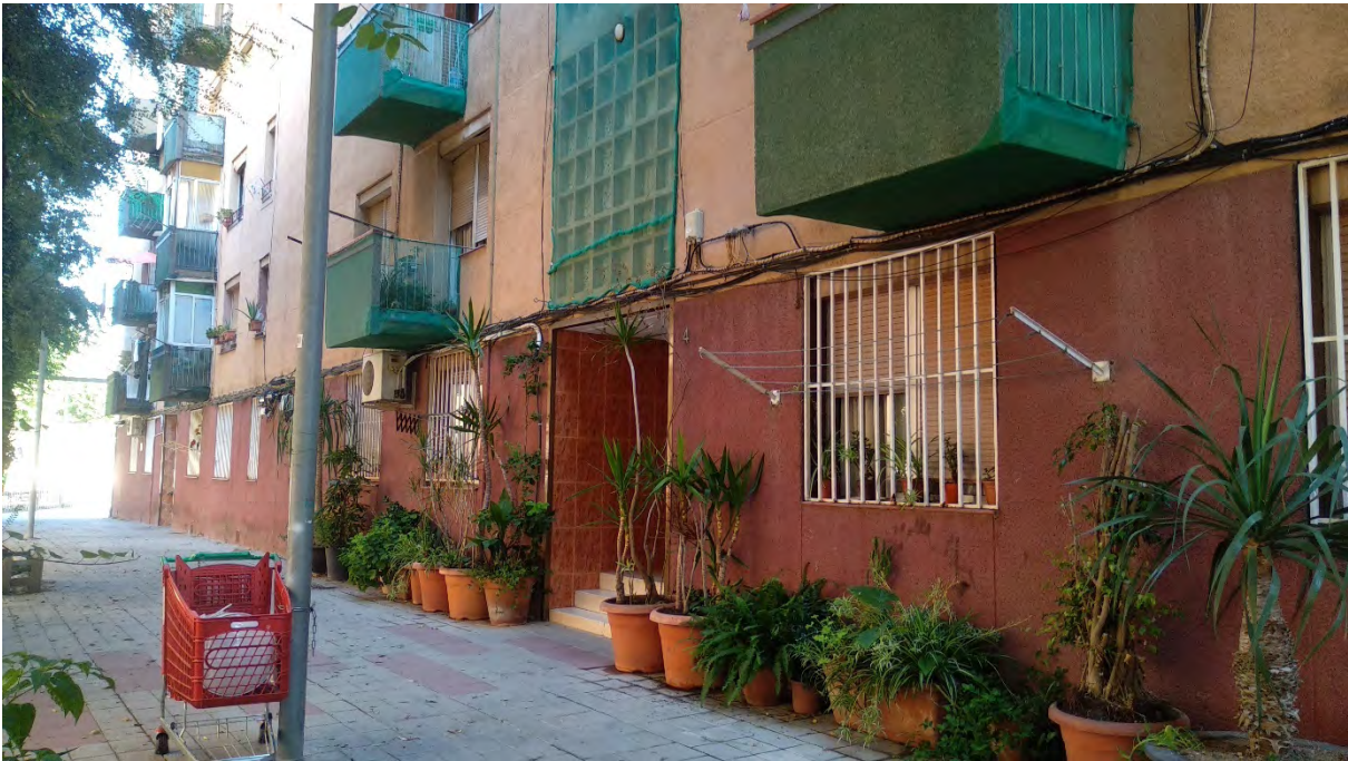
Imatge 16. Vista de la façana de c/ Tessàlia 4.
