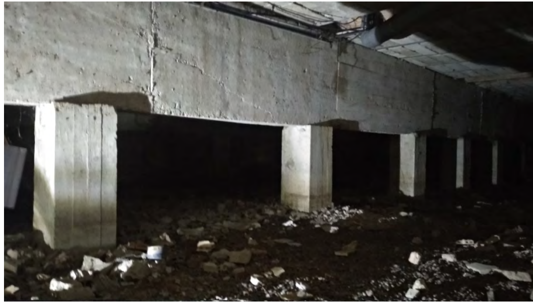
Imatge 9. Jàssera d'estintolament de la paret de carrega central de l'edifici.
