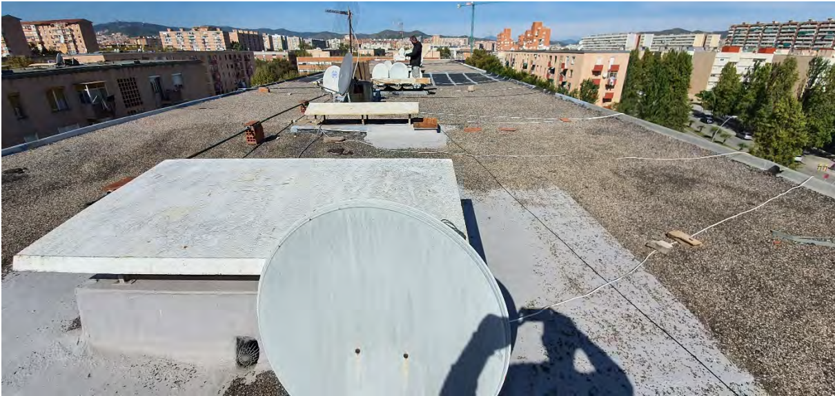
Imatge 14. Vista parcial de la coberta.
