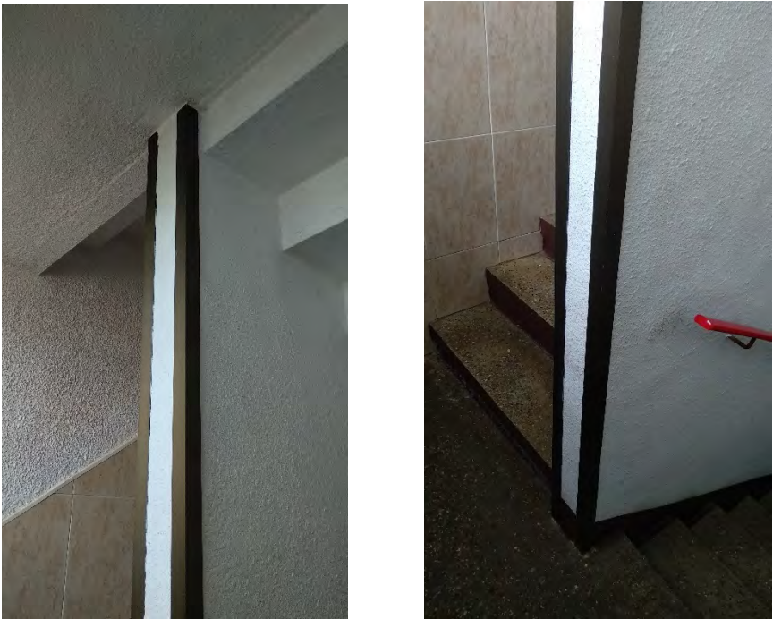
Imatge 4-5. Vistes del mur portant.
