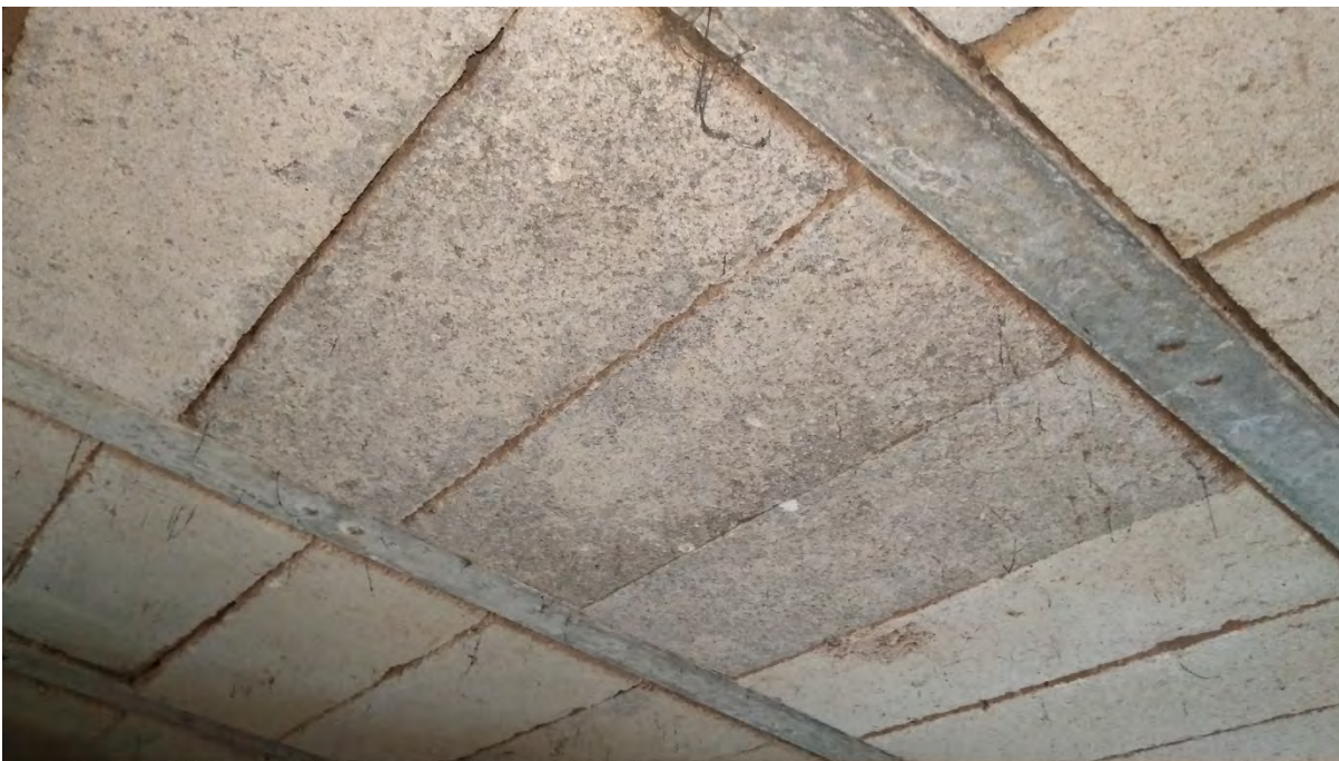
Imatge 6. Vista de l'estructura horitzontal de sostre unidireccional de biguetes de formigó (cambra sanitària)
