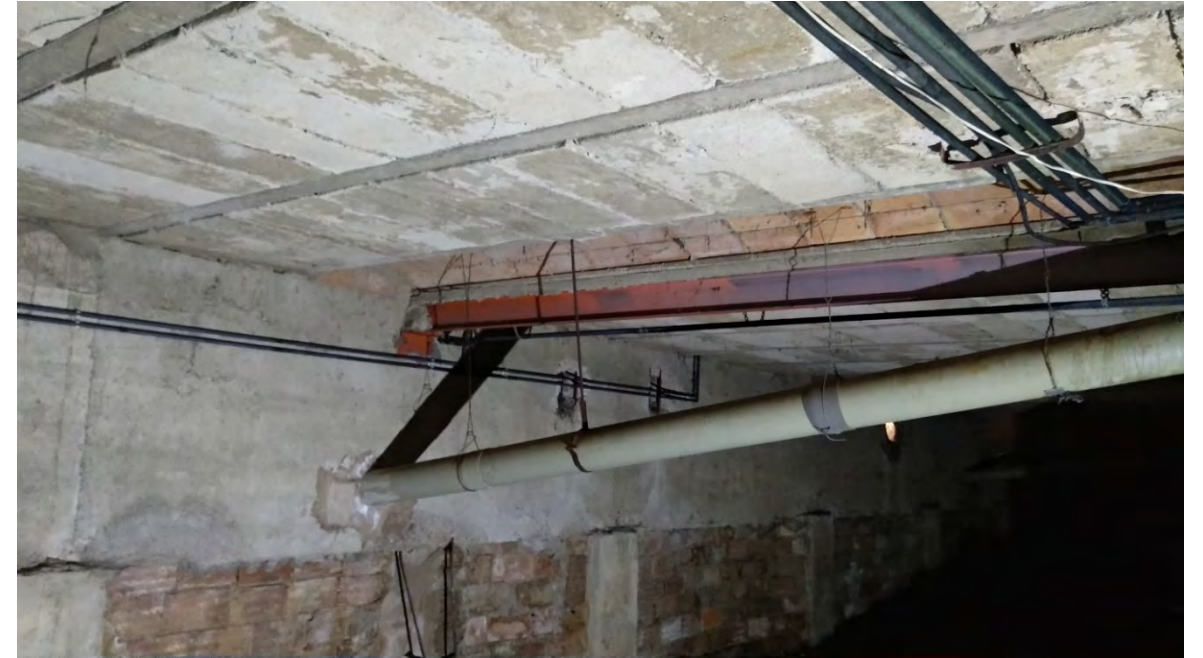
Imatge 25. Vista de la xarxa de sanejament.
