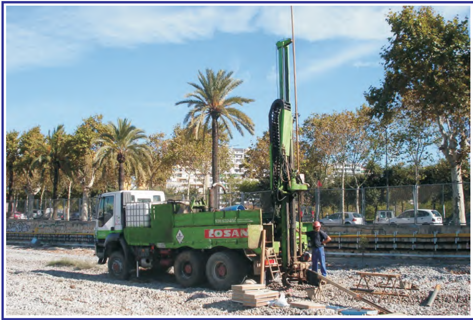
Ejecución del sondeo PZ-2D.
