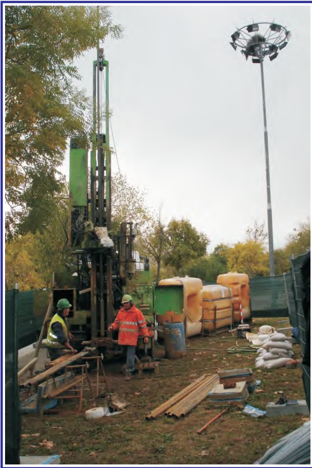
Ejecución del sondeo PZ-5D.
