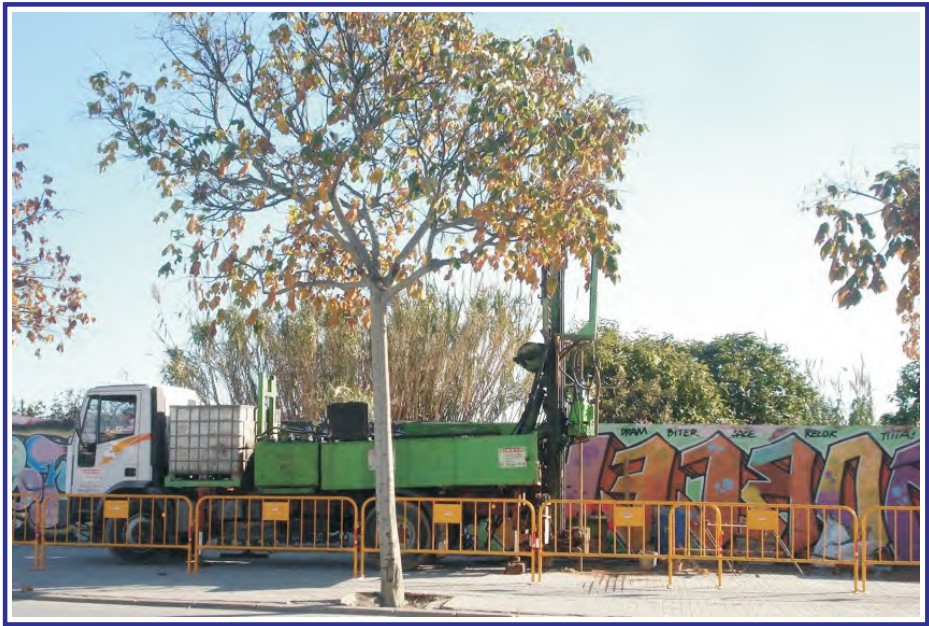
Ejecución del sondeo PZ-10I.
