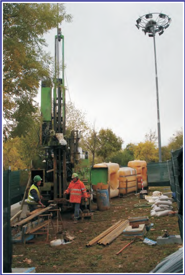
Ejecución del sondeo PZ-6D.
