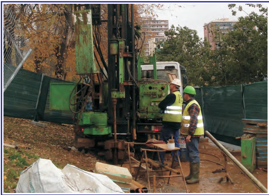
Ejecución del sondeo PZ-8D.
