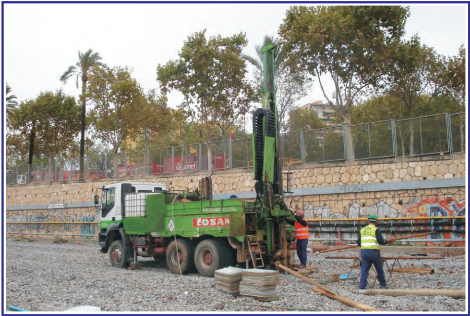
Ejecución del sondeo PZ-3D.
