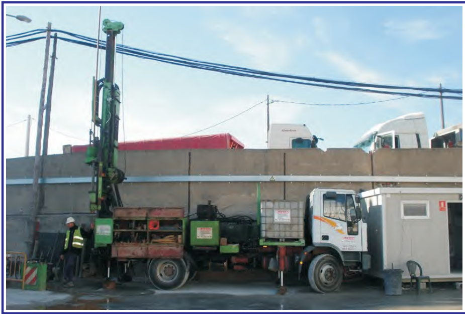
Ejecución del sondeo PZ-8I.
