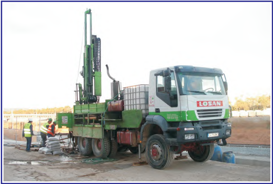
Ejecución del sondeo PZ-2I.
