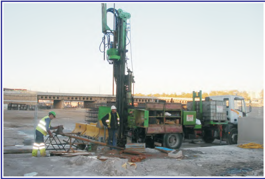
Ejecución del sondeo PZ-9I.
