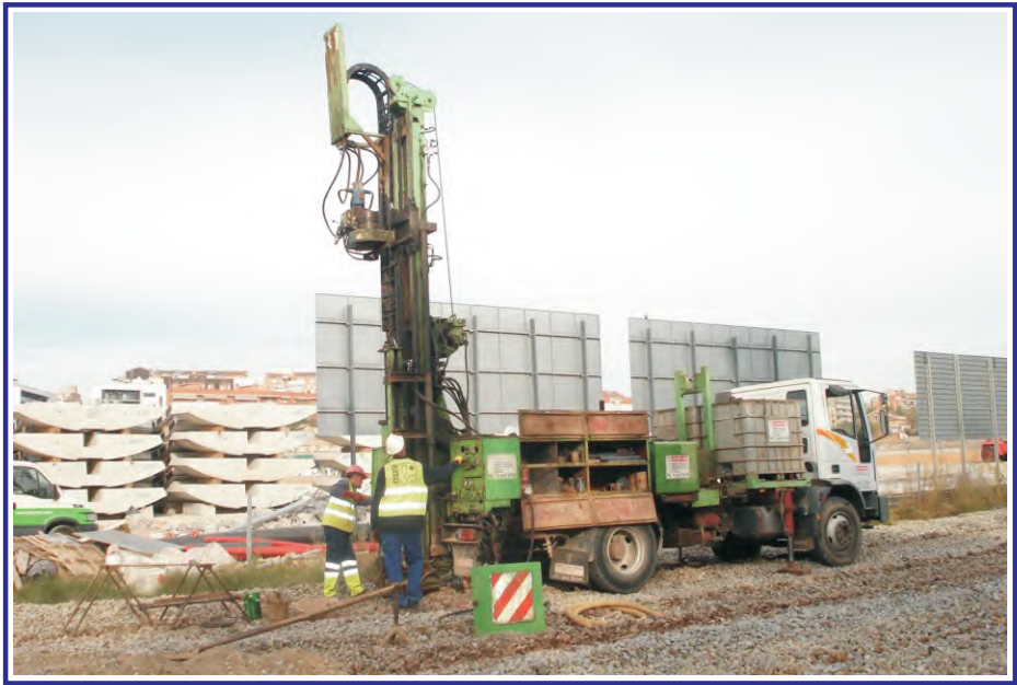
Ejecución del sondeo PZ-1D.
