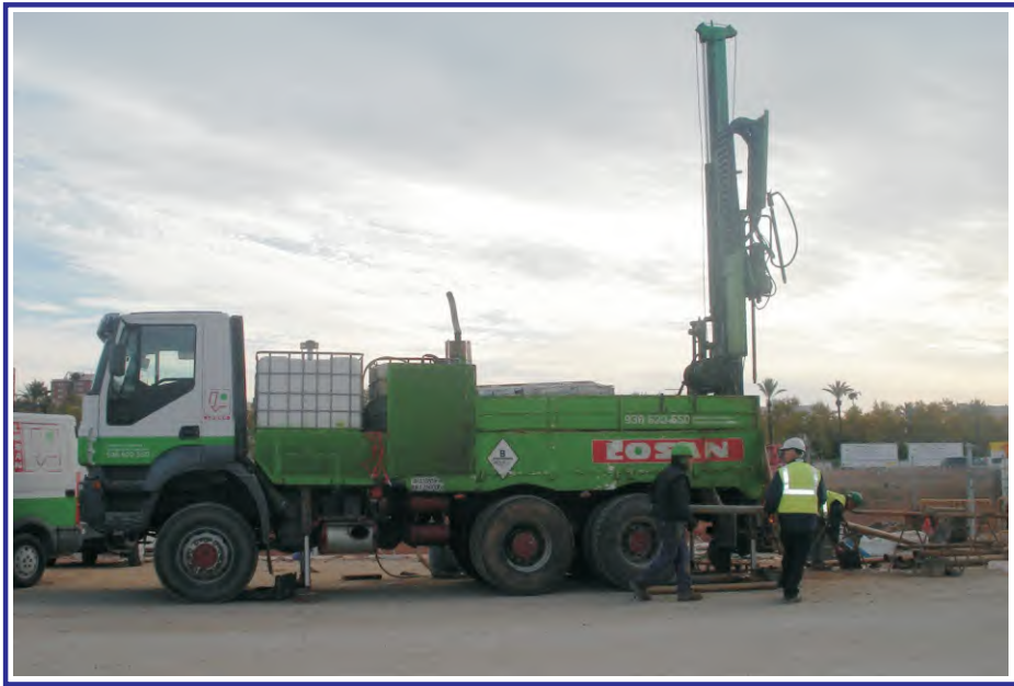
Ejecución del sondeo PZ-3I.
