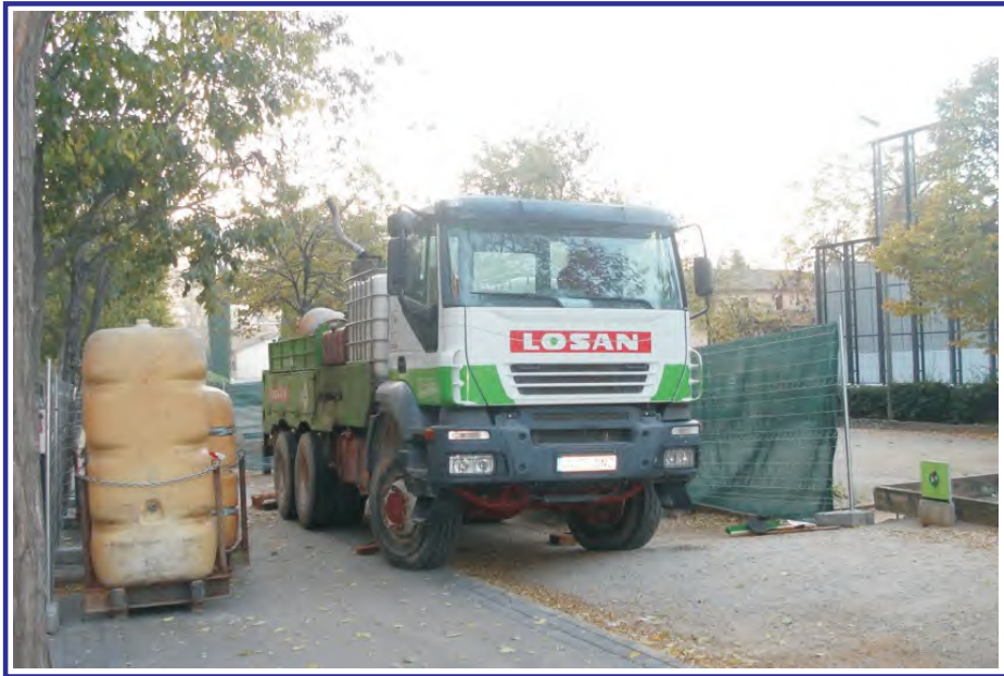
Ejecución del sondeo PZ-9D.
