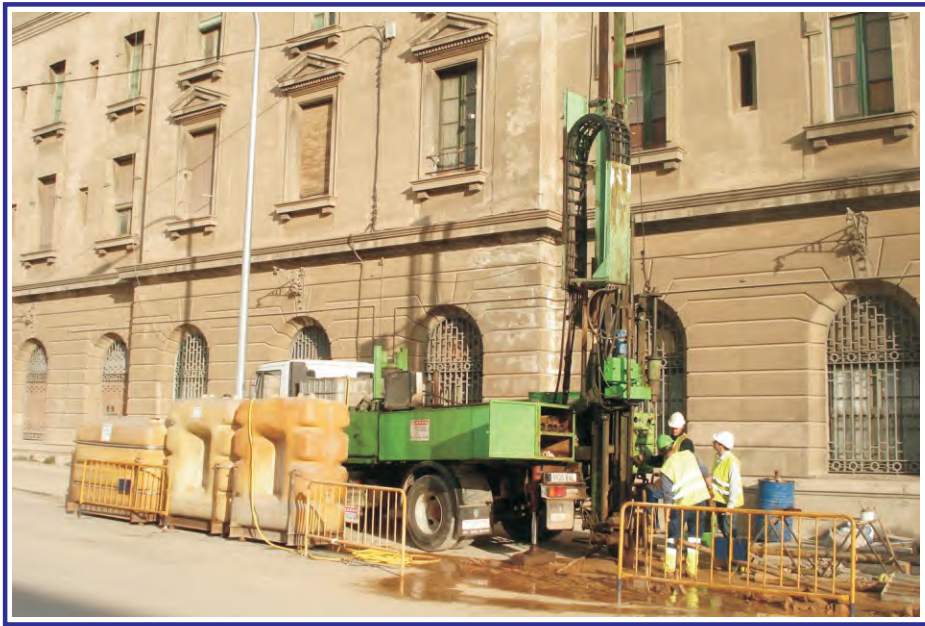
Ejecución del sondeo PZ-7I.
