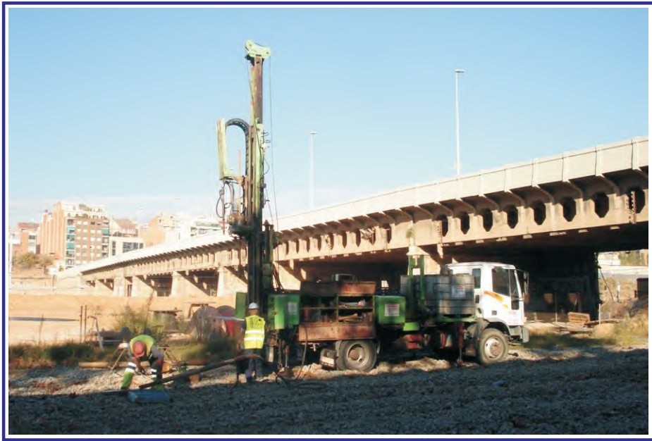
Ejecución del sondeo PZ-4D.
