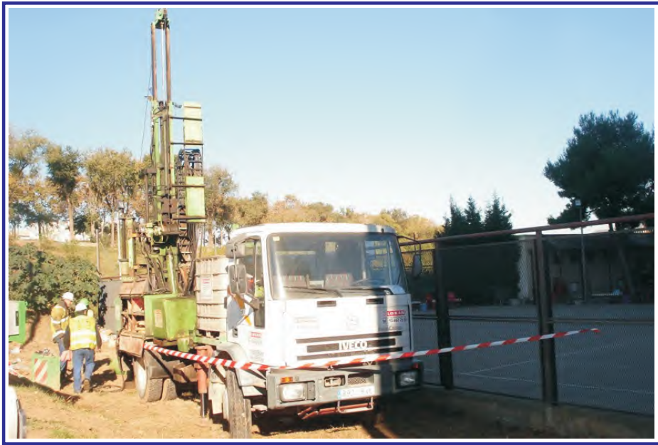
Ejecución del sondeo PZ-7D.
