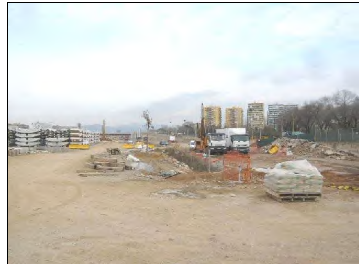
Fotografía Nº 5.I. Zona de trabajo
