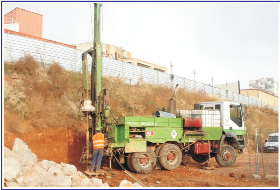
Ejecución del sondeo PZ-6I.
