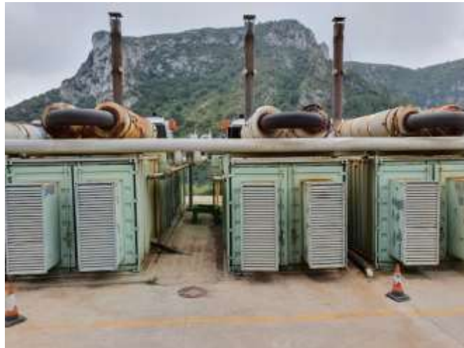
Figura 1. Contenedores que albergan los motores.
