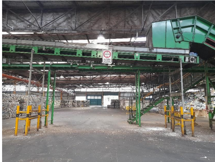
Área de construcción de la cabina de triaje
