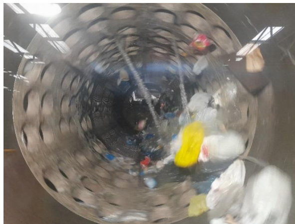
Imagen del interior del tromel
