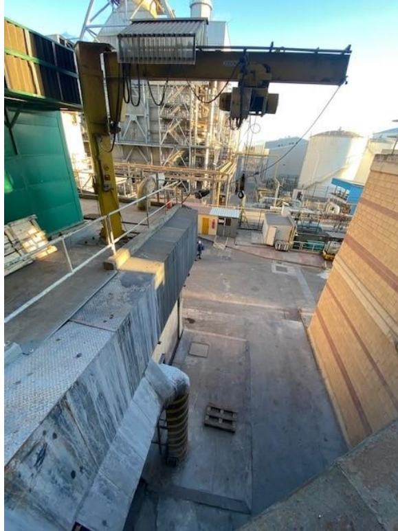
Imagen 2.- Polipasto zona turbina lado Besòs cota +7.00m
