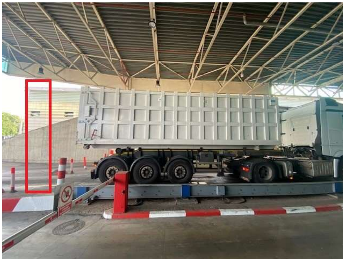
Fig.5.- Ubicación de los paneles de detección radiactiva a la entrada de la báscula lado BCN
