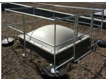
Figura 3. Ejemplo protección claraboyas con barandilla
