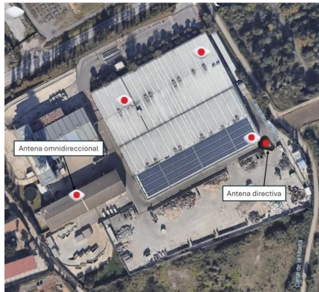
Il·lustració 1 - Ubicacions de les antenes desplegades actualment
