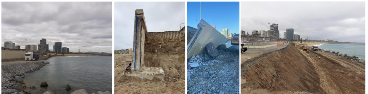
Imatges d'obres de reconstrucció del mur. Font: Ajuntament de Barcelona.
