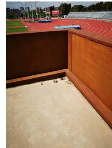
AMPIT REVESTIT D' CER COR-TEN
