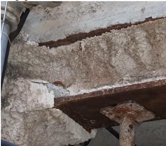
Recolzament a pilar
