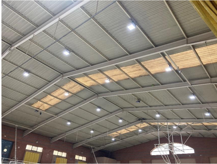
Fotografia 01: Estructura d'acer zona pavelló.
