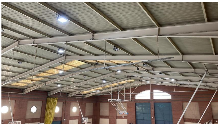
Fotografia 02: Estructura metàl·lica, amb presència d'instal·lacions.
