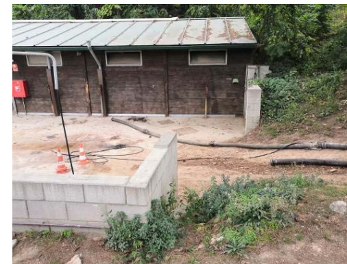
Mur de bloc al pas cap a pistes que actua de barana
