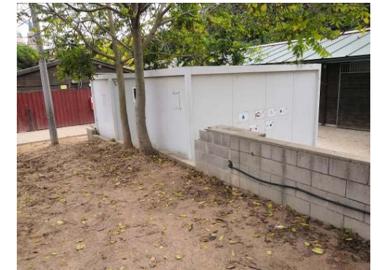
Pas entre pistes i mur de bloc de formigó
