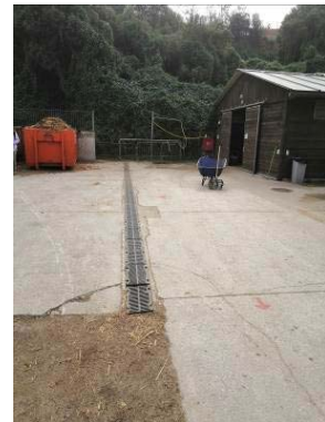
Canal a substituir i allargar
