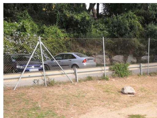
Tanca amb malla de simple torsió a la zona d'accés
