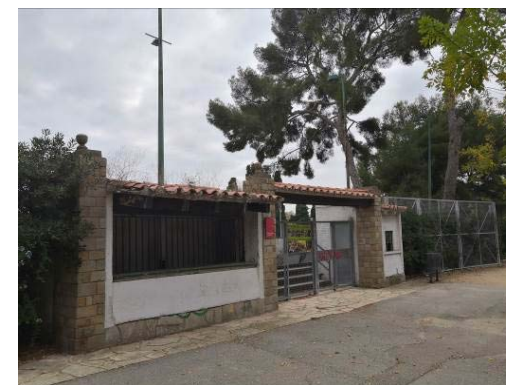
Casetes a enderrocar i pilastres a conservar
