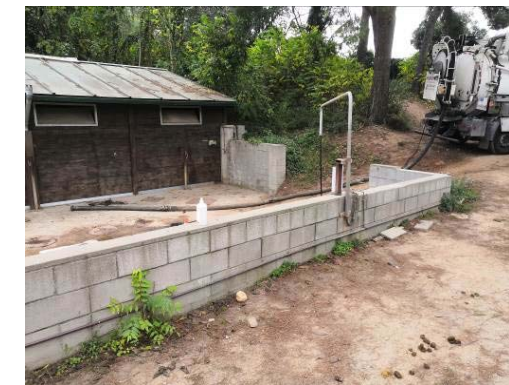
Mur de bloc al pas cap a pistes que actua de barana
