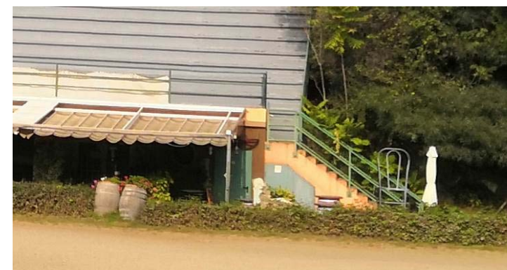
Baranes on s'ha de substituir la malla de simple torsió. Escales als laterals
