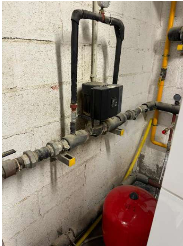
Bomba circuladora de primari i vas d'expansió.
