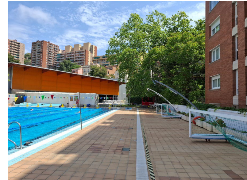
Imatge 3. Entorn, edifici afectat per soroll
