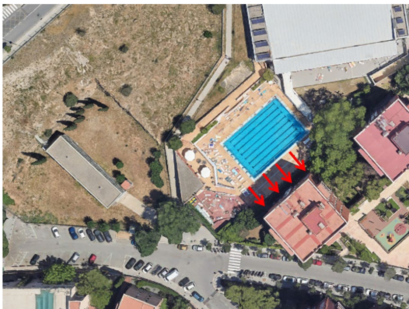
Imatge 2. Entorn, edifici afectat per soroll
