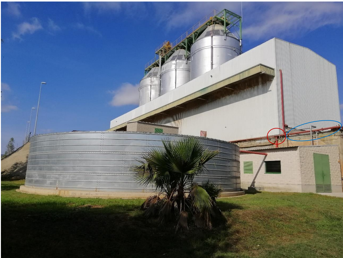
Imagen 2: Sistema de bombeo actual (conexión existente, círculo rojo) y tubería existente desde el nuevo grupo de bombeo a pintar (azul)
