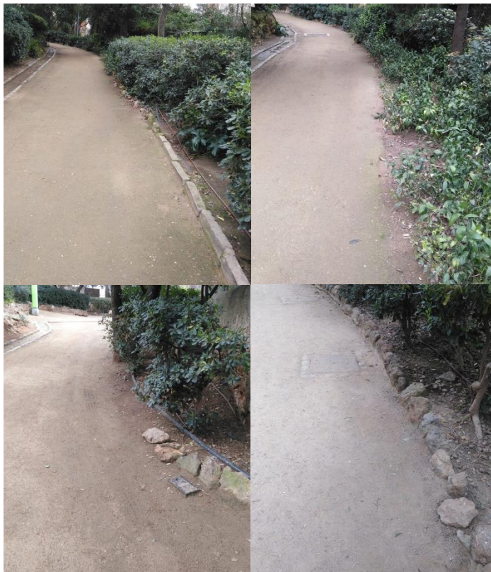
Figura 4. Encintat de pedra que caldria refer com a millores en el parterre lateral del parc de Monterols entrant per les escales de Gualbes.
