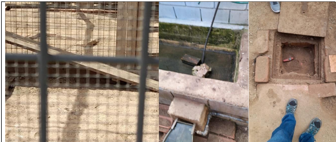
Imatge 1. Tauló per pujar a la basa, verdet a la basa, clau de pas protegida per maons i plena de terra.
