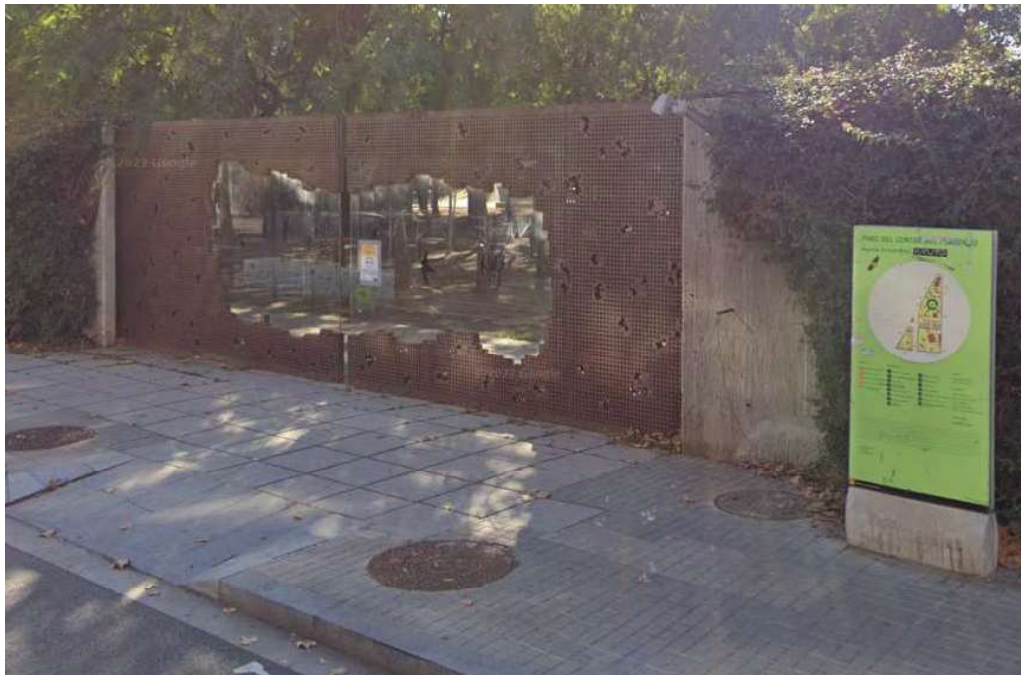
Porta de dos fulls d'accés al Parc del Carrer Bac de Roda més propera al carrer Marroc i que actualment esta tancada i sense poder obrir-se.
