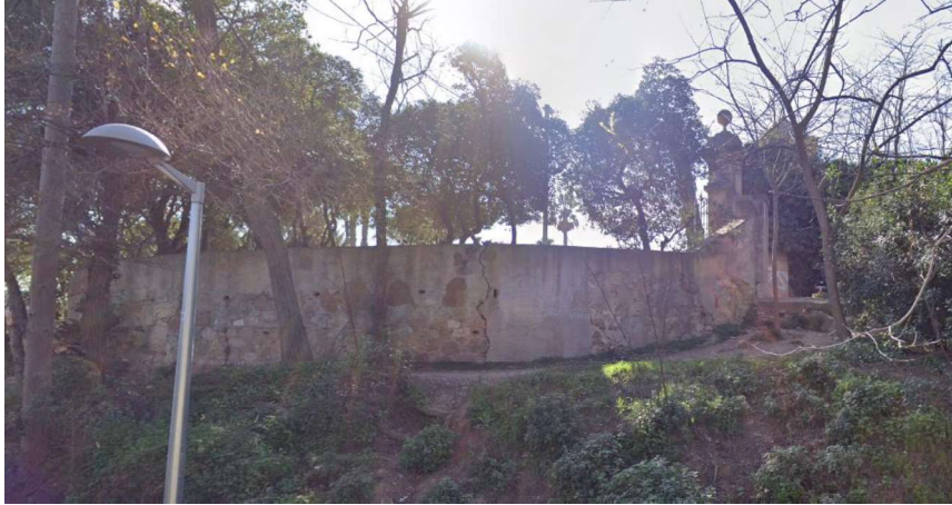
Zona 1: portal d'accés a finca.
