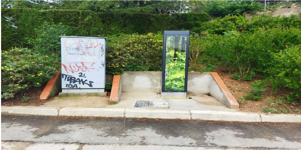
Foto d'exemple per proposta d'ubicació d'armari elèctric dins d'un espai enjardinat situat en el accés al parc del Laberint d'Horta.
