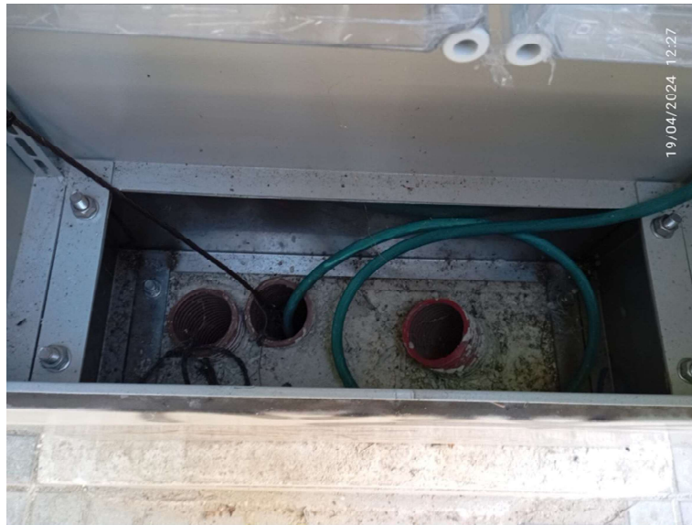
Foto 3 tubs entrada cablejat armari existent
